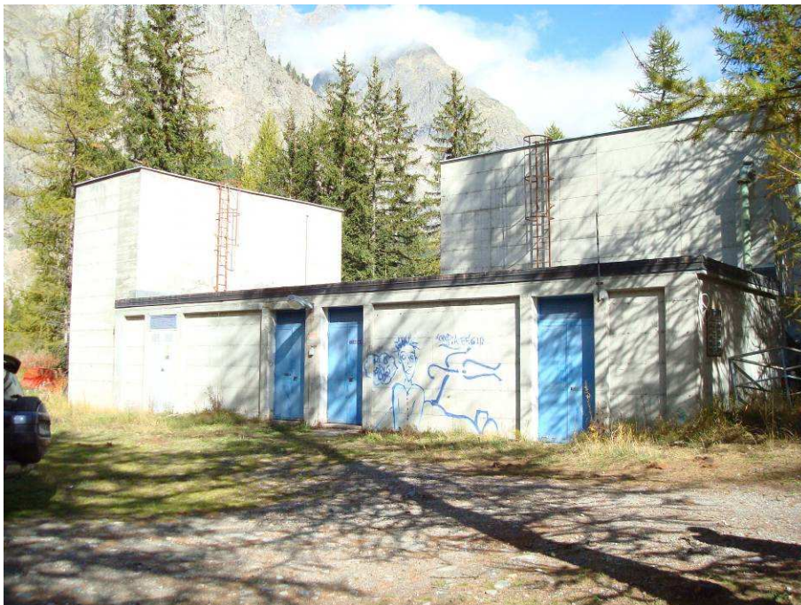
Stazione di innevamento interessata da interventi
