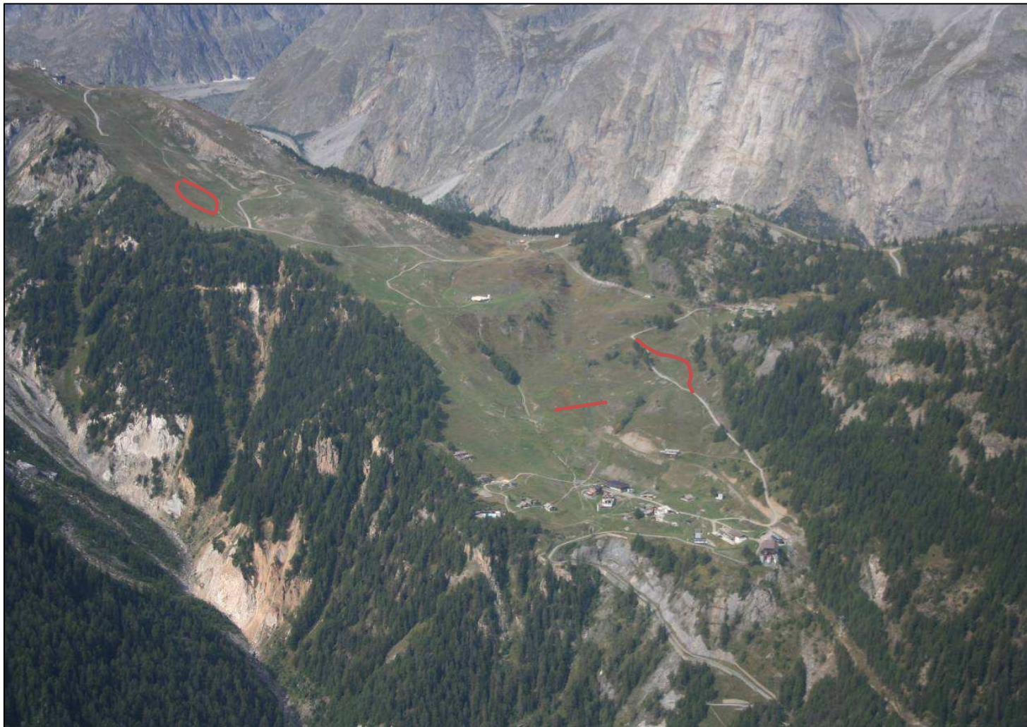
Foto panoramica dell'area (in rosso l'intervento)
