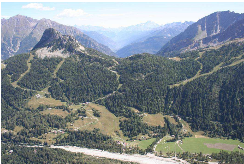
Zona del comprensorio lato Val veny interessata dagli interventi
