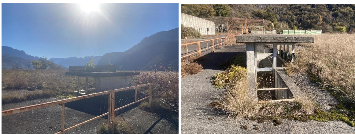
Figura 4.6: dettaglio delle fosse di tiro
