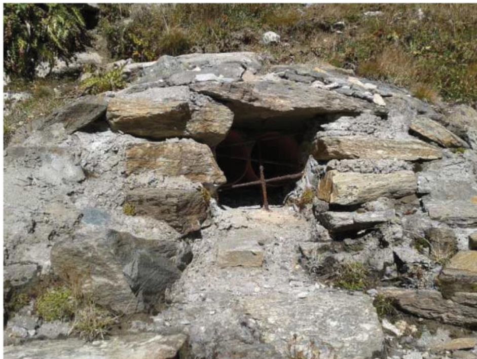
Figura 3-1 Opera di presa idropotabile su sorgente “Grande Fontaine”
