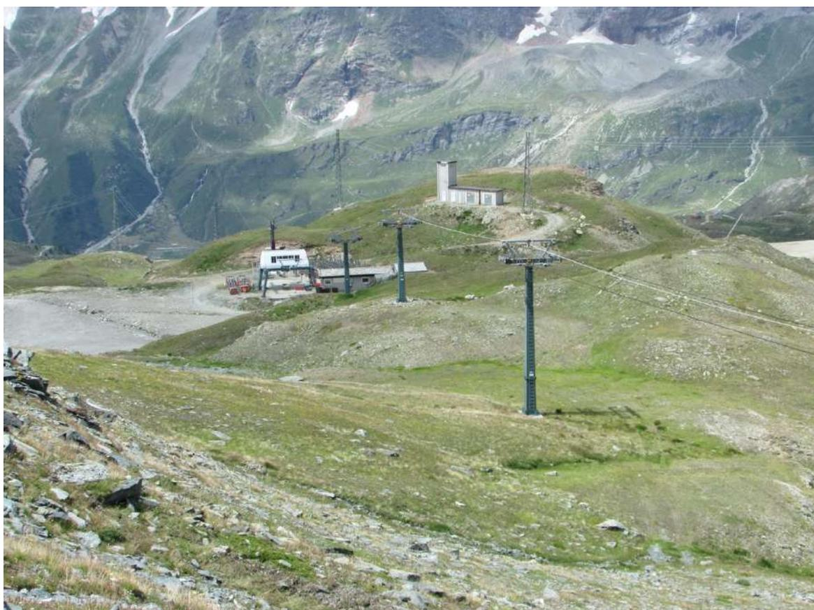
*Foto della stazione di valle con i primi 3 sostegni intermedi*
