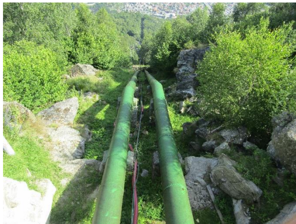
Vista generale della condotta forzata
