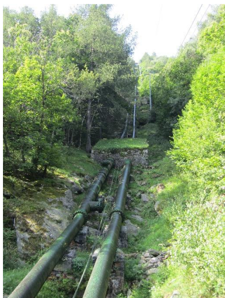
Vista generale della condotta forzata
