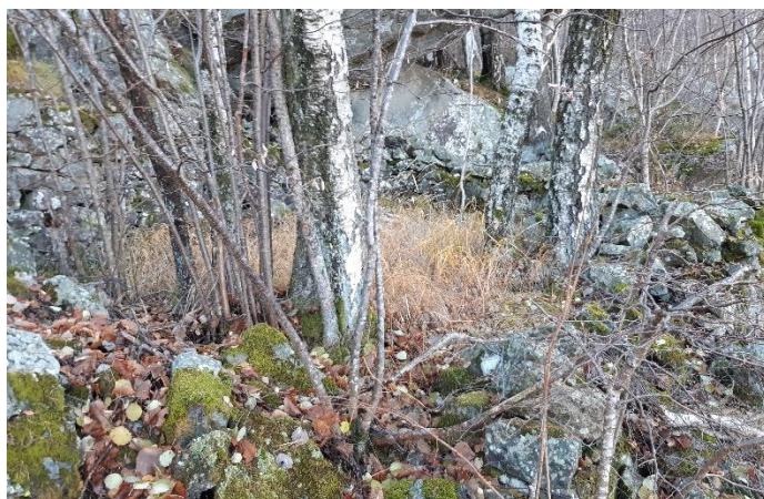
Edificio diroccato presso l'area di realizzazione della vasca di carico (foto fornita dalla committenza a seguito del sopralluogo del 19/11/2021)
