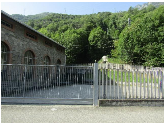
Area di intervento presso la centrale Hône II
