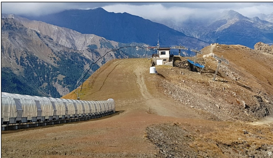
FIGURA 4-18 STAZIONE DI MONTE ATTUALE COUIS I E TAPPETO PLATTA
