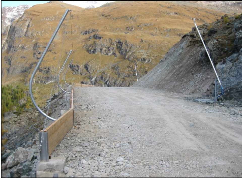
FIGURA 4-90 ESEMPIO DI INSTALLAZIONE DELLE STRUTTURE DI SOSTEGNO PER RETI DI TIPO A
