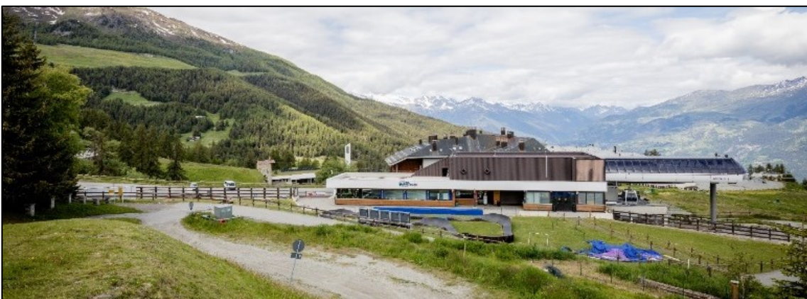
FIGURA 4-30 STAZIONE DI ARRIVO DELLA TELECABINA AOSTA-PILA
