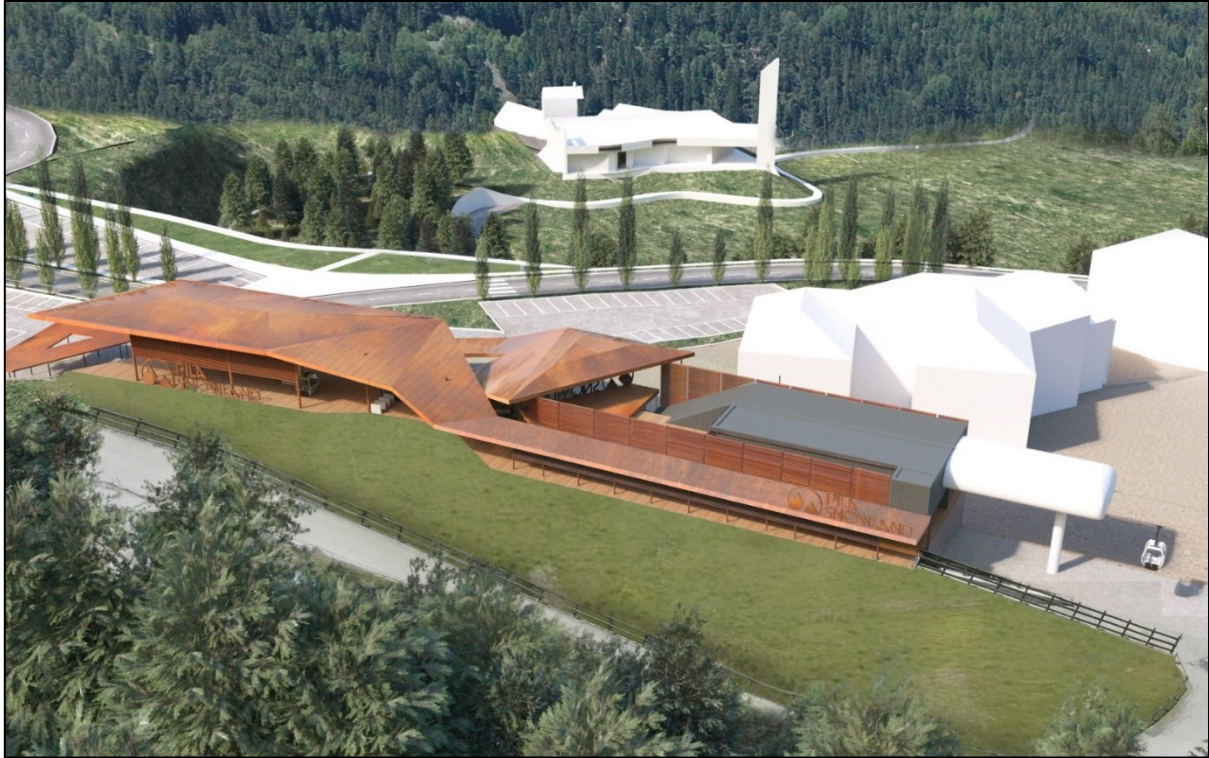
FIGURA 4-34 NUOVA STAZIONE DI VALLE TELECABINA "PILA-COUIS"
