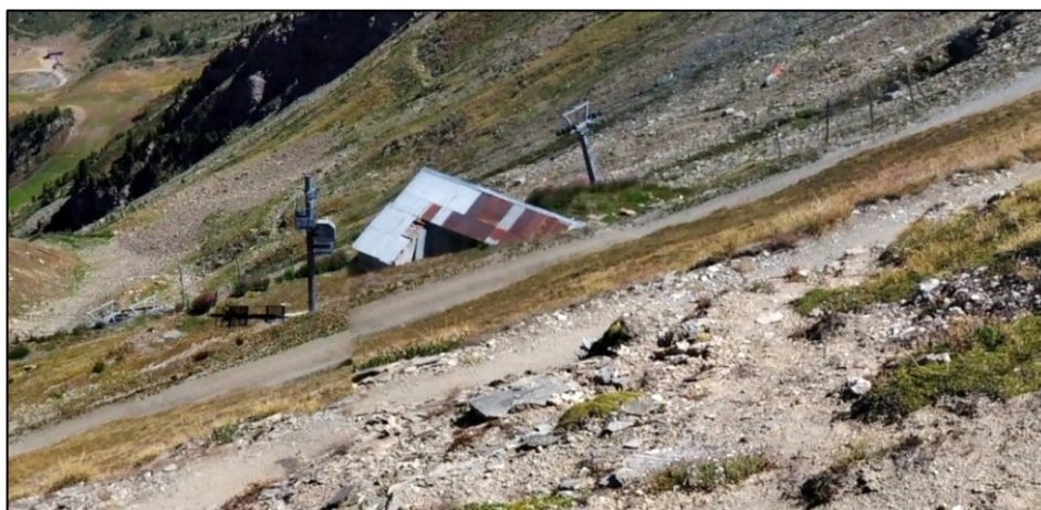
FIGURA 4-94 STRUTTURA METALLICA DA DISMETTERE
