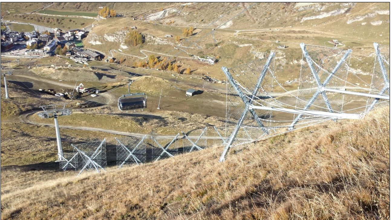
FIGURA 4-71 ESEMPIO DI INSTALLAZIONE ELEMENTI FERMANEVE MONOANCORAGGIO "A OMBRELLO" ZINCATI
