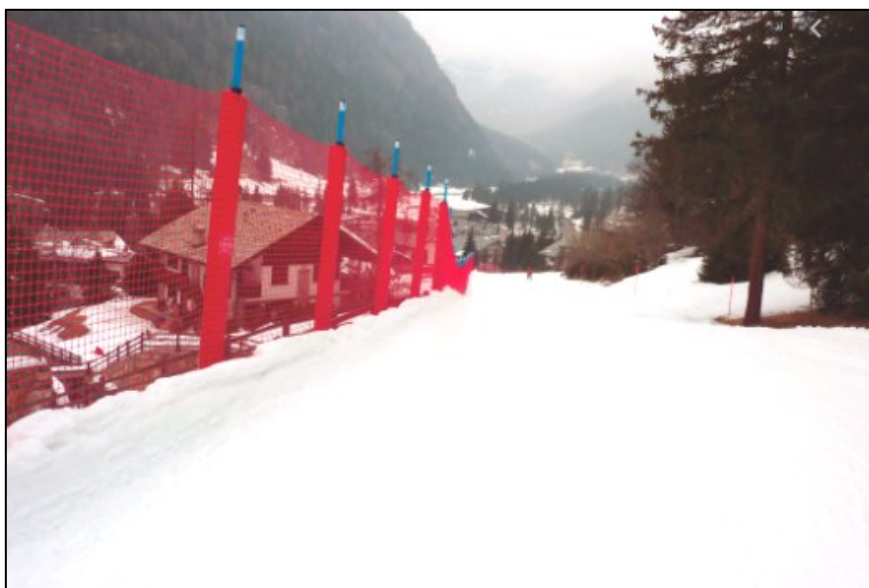
FIGURA 4-91 ESEMPIO DI INSTALLAZIONE RETI DI TIPO A/B
