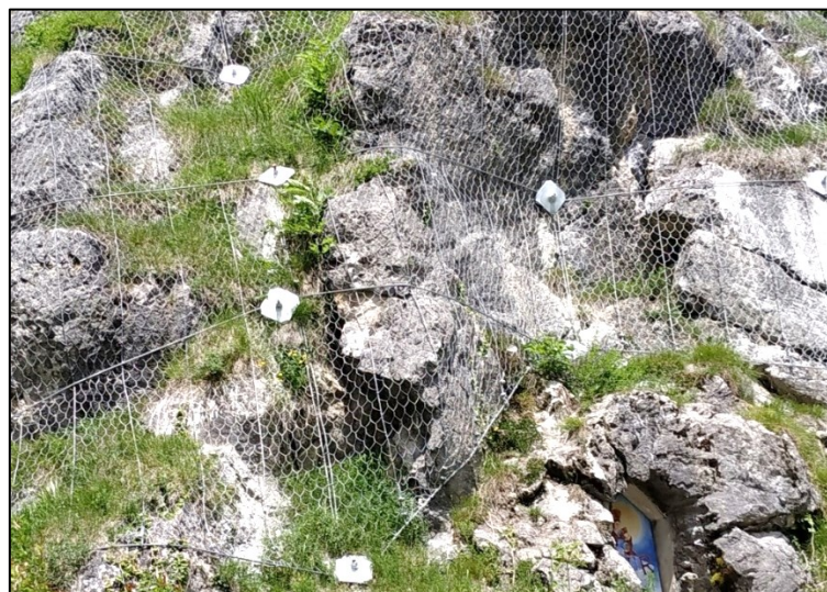
FIGURA 4-78 ESEMPIO DI INSTALLAZIONE RAFFORZAMENTO CORTICALE – SETTORI A - B
