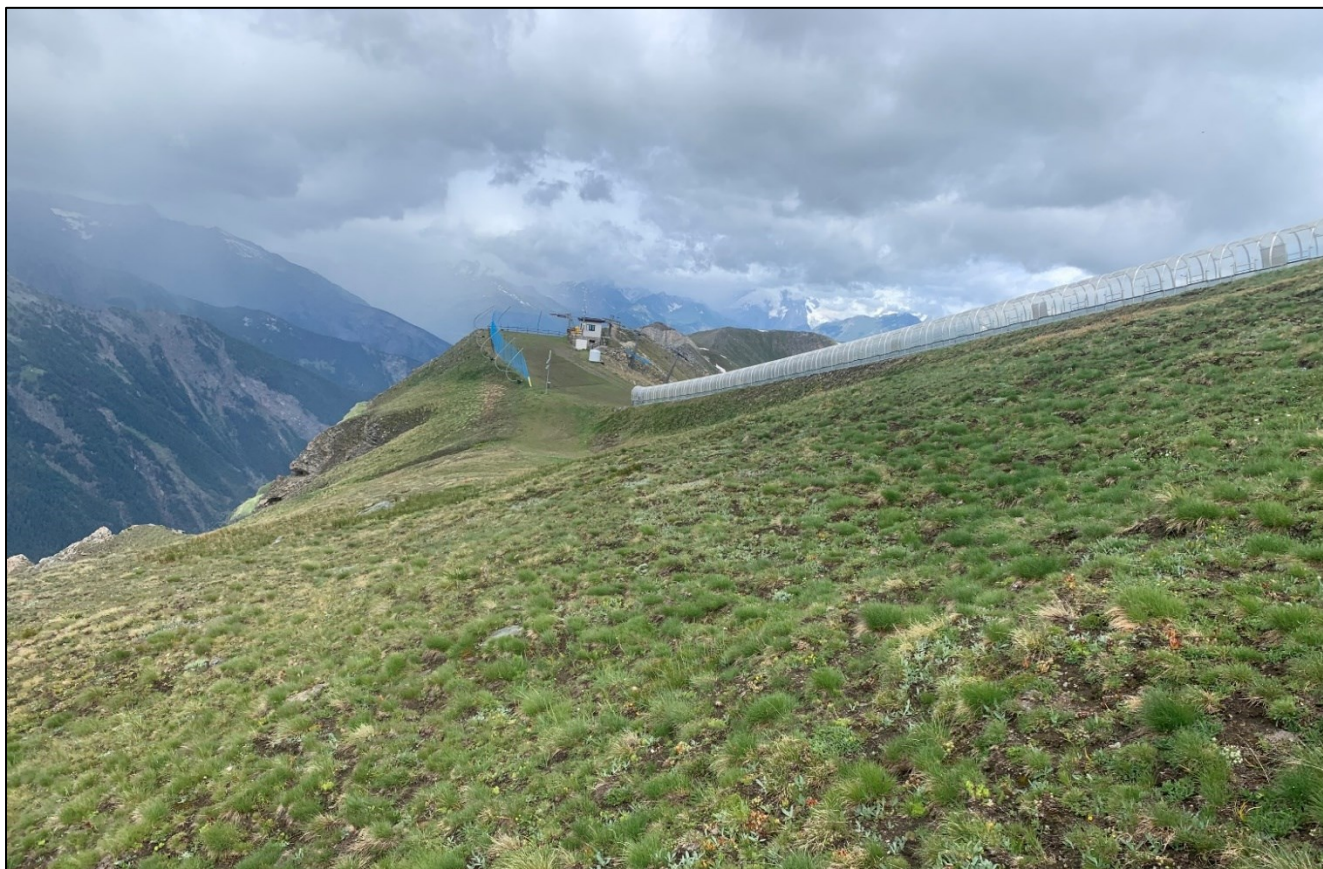
FIGURA 4-54 VERSANTE SUD DELLA PLATTA DE GREVON
