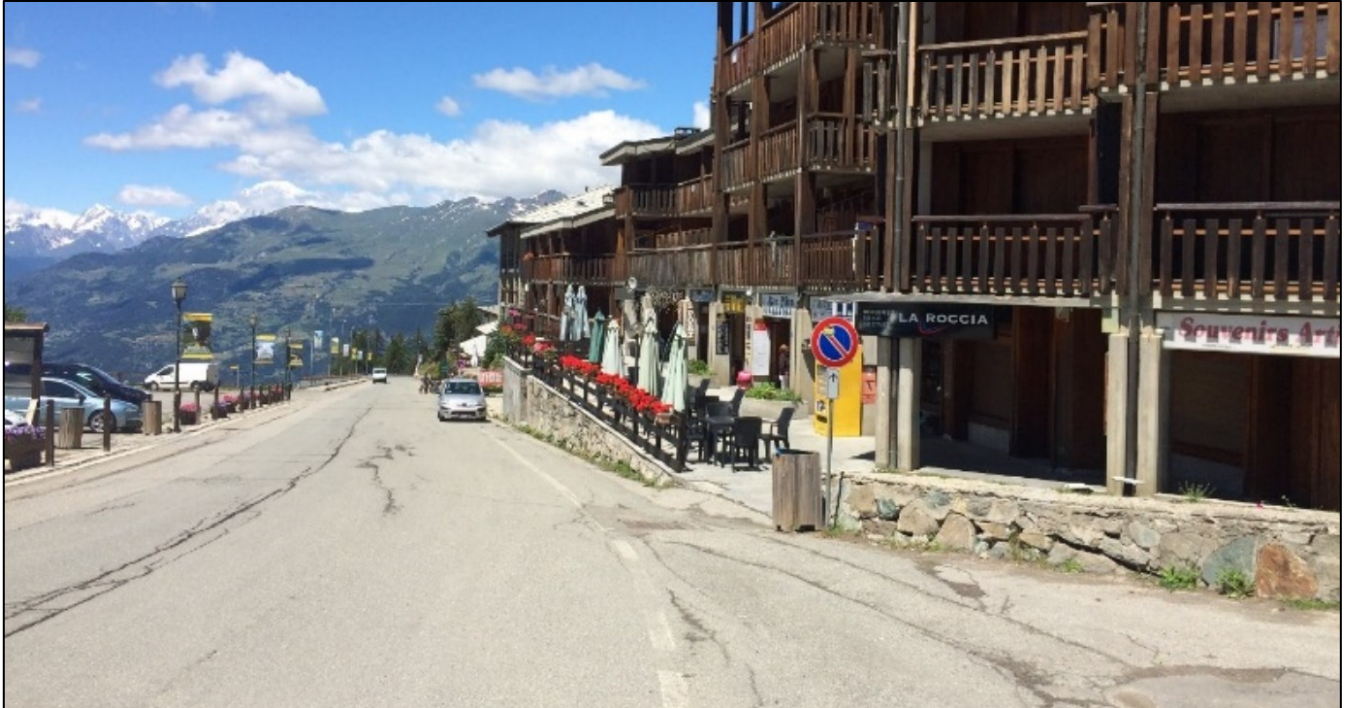
FIGURA 4-31 CORTINA EDILIZIA LUNGO LA STRADA REGIONALE
