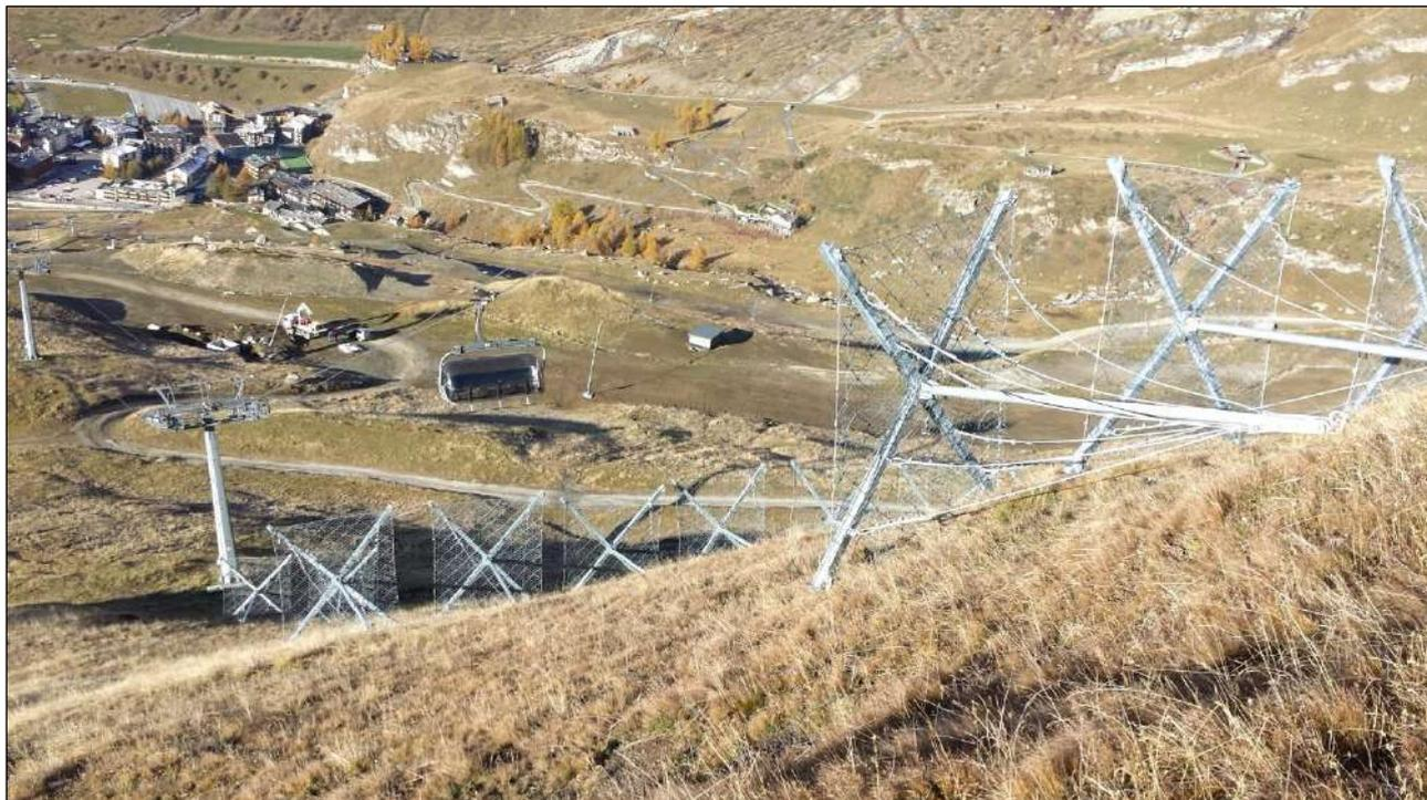
FIGURA 7-67 ESEMPIO DI INSTALLAZIONE ELEMENTI FERMANEVE MONOANCORAGGIO “A OMBRELLO” ZINCATI
