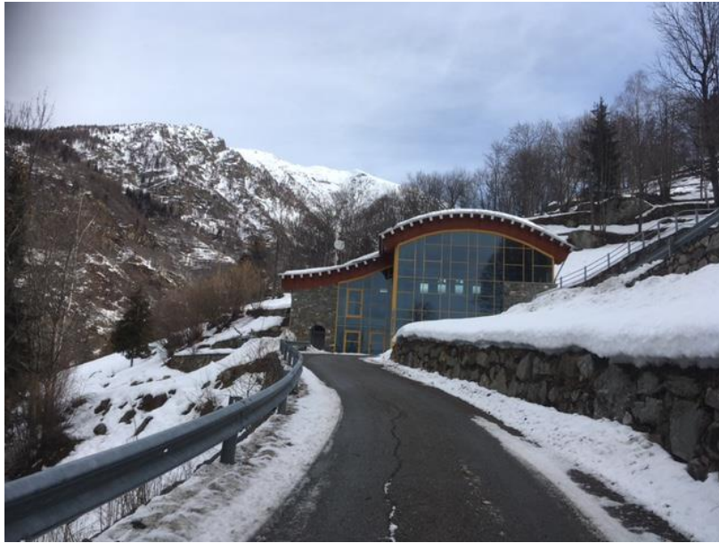
Fig. 6: Pillaz. La centrale esistente dalla quale partirà il tracciato (foto da ricognizione Akhet).
