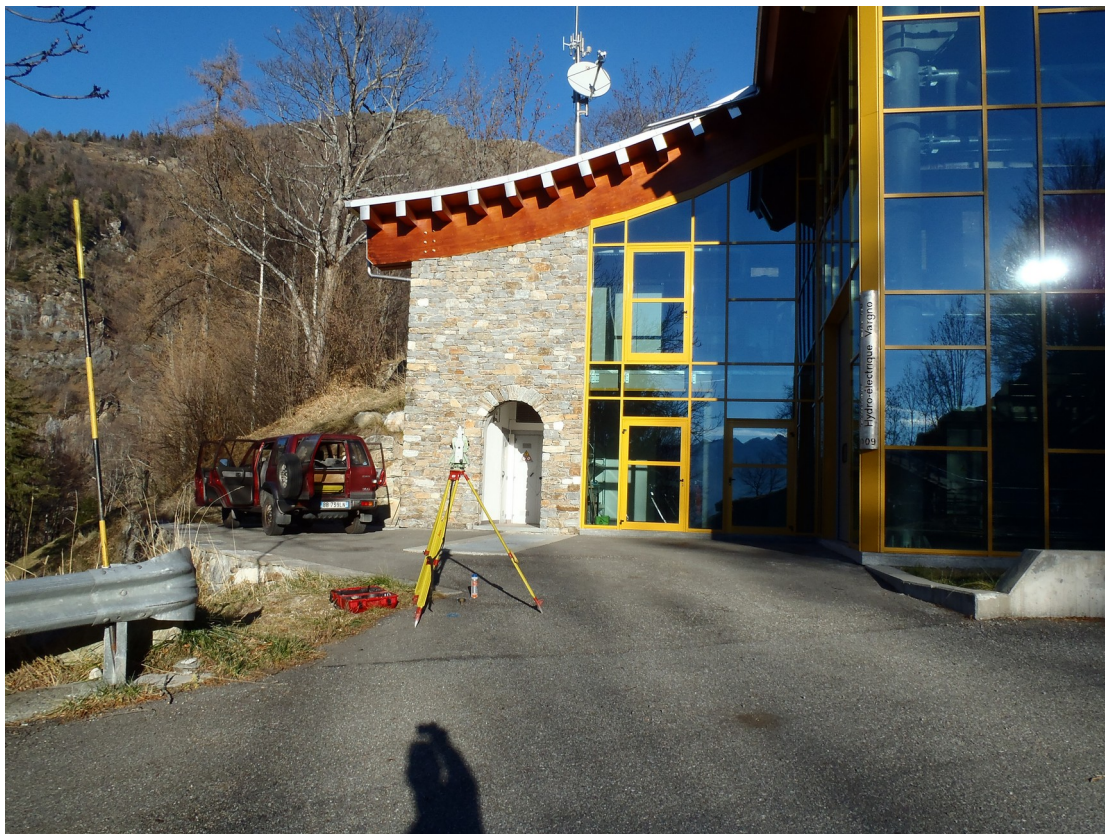
Vasca di carico esistente sul piazzale antistante la centrale Pillaz
