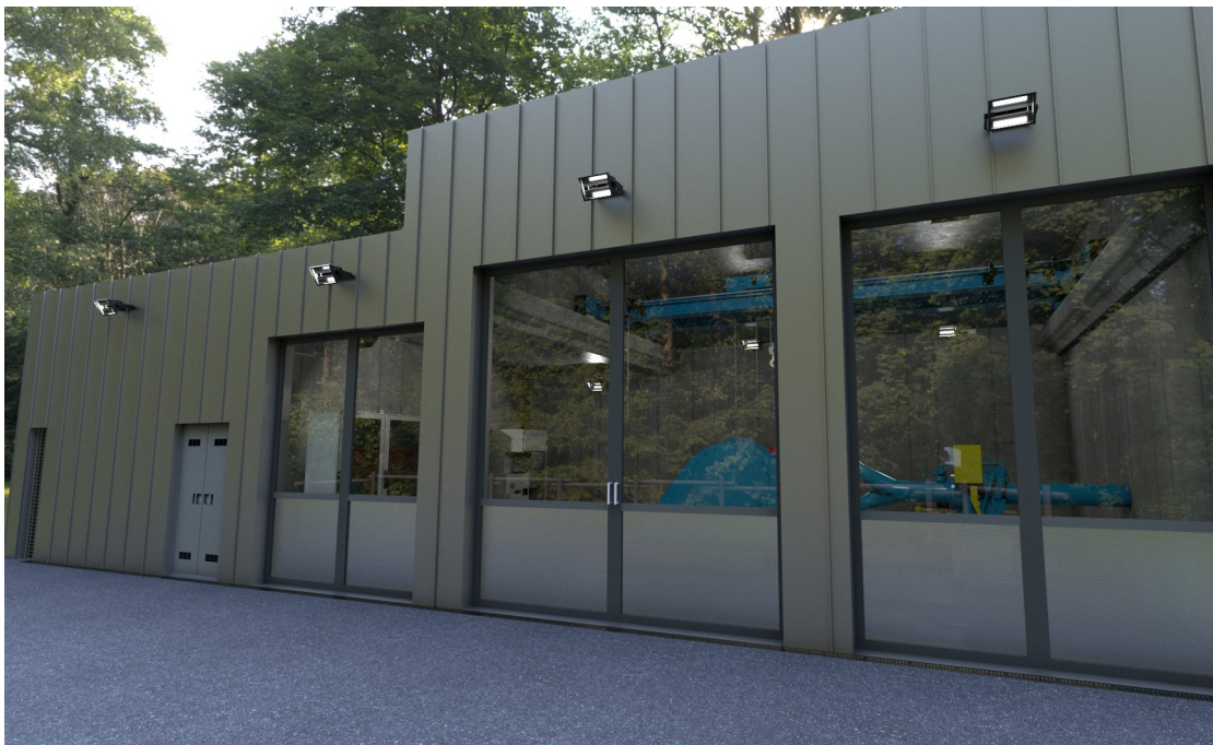
Figura 6: Prospetto esterno del locale centrale
