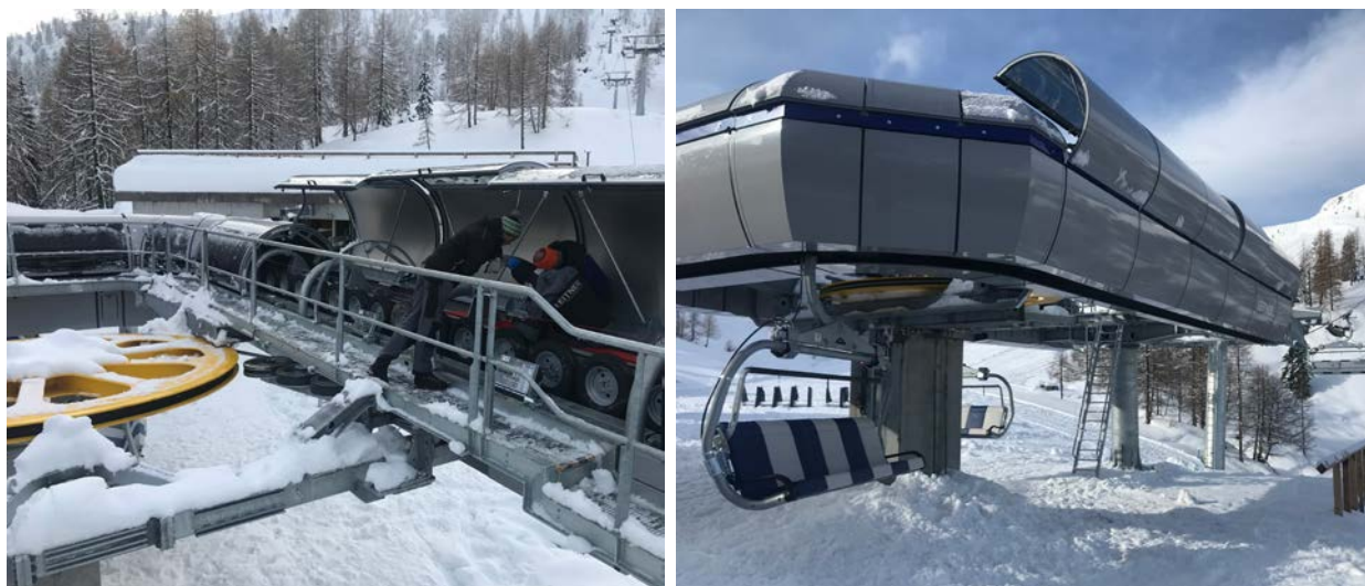
Figura 7. Esempio di stazione con copertura di "tipo basso" nella quale la puleggia risulta esposta alle intemperie e solo i meccanismi di sincronizzazione del giro stazione sono protetti da una carenatura sollevabile per le manutenzioni e le ispezioni. Le foto mettono in evidenza come in presenza di forte vento le carenature non possano essere aperte impedendo di fatto l'esecuzione di qualsiasi controllo o intervento di manutenzione.
