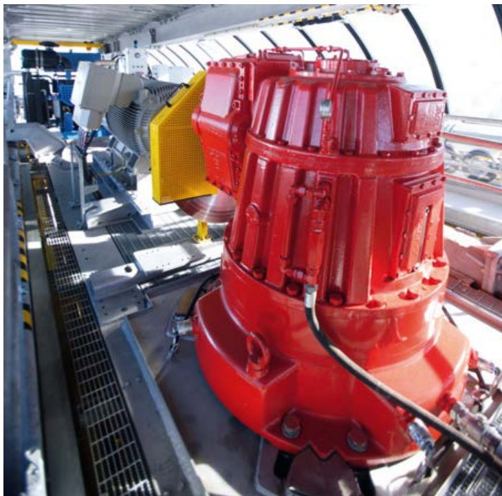
Figura 10. Argano principale tradizionale: motori-disco freno-riduttore epicicloidale-puleggia.
