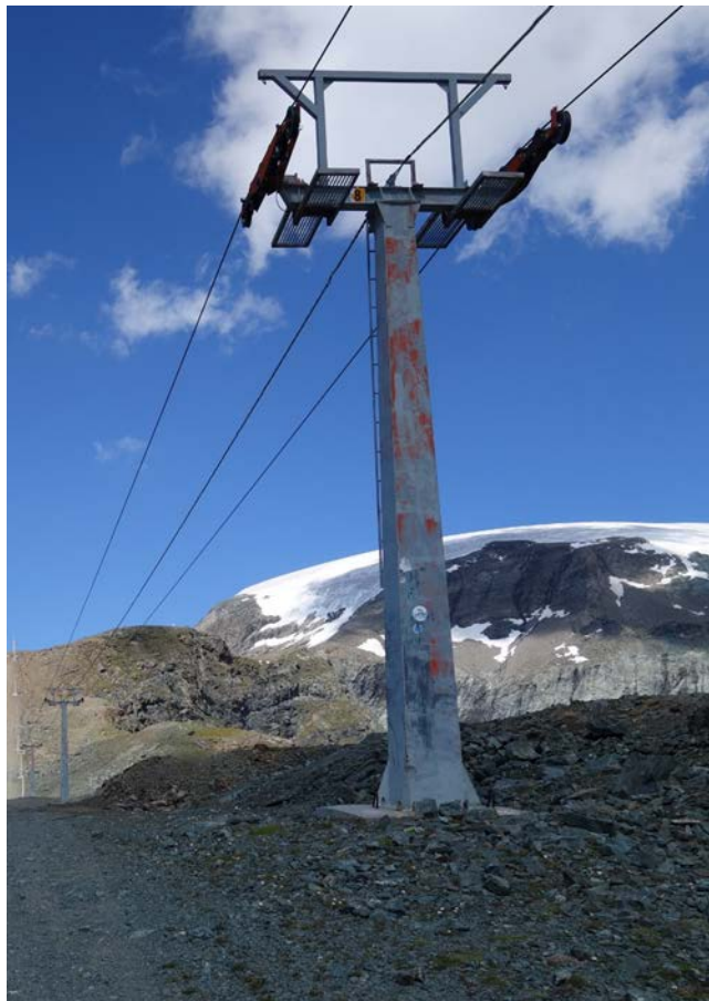
Figura 4. Opere di linea: sostegno a portale e sostegno a ritto centrale.
