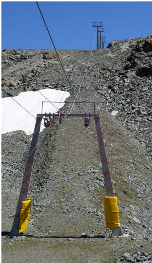
Figura 4. Opere di linea: sostegno a portale e sostegno a ritto centrale.
