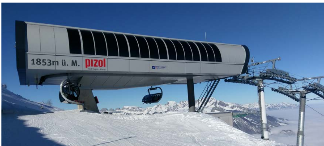
Figura 5. Esempi di stazioni seggiovia esaposto con stazione di "tipo alto" realizzate ai tra costruttori funiviari presenti sul mercato (dall'alto verso il basso): Leitner, Doppelmayr e Bartoletti.
