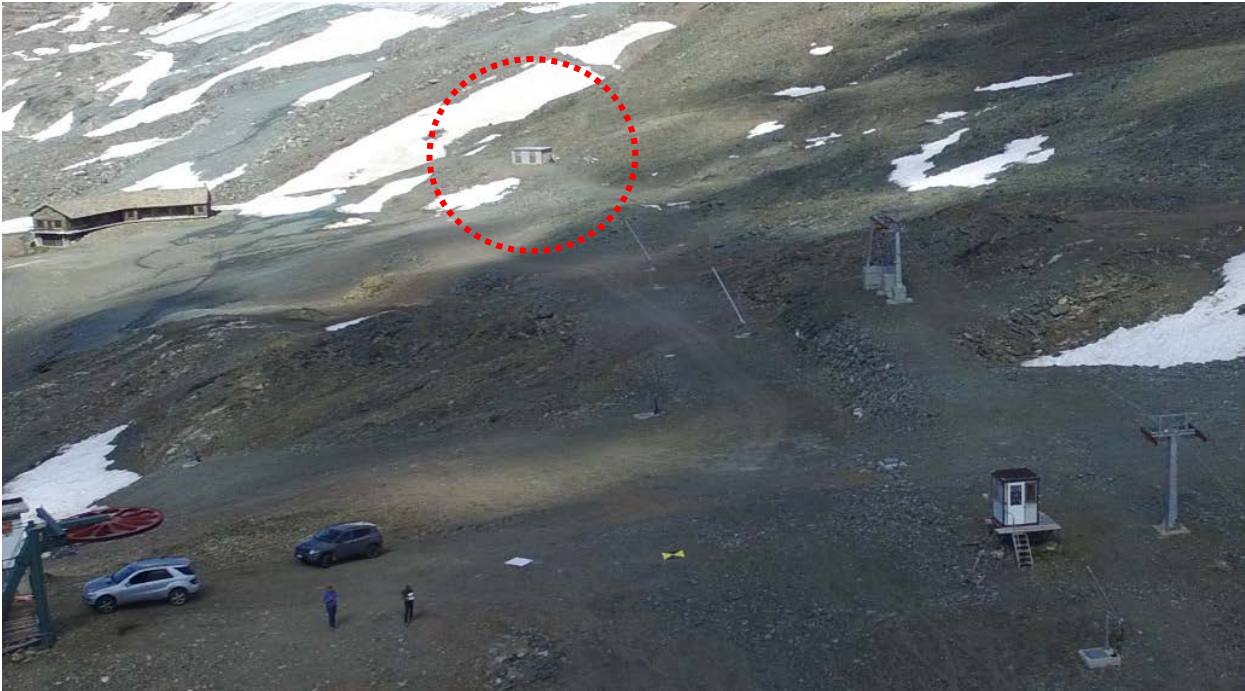
Figura 23. Posizione della cabina elettrica di media tensione esistente nei pressi della stazione di monte della nuova seggiovia. Il cerchio rosso indica il locale da cui derivare l'alimentazione elettrica.
