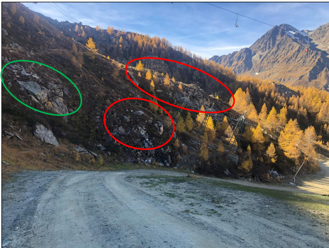
FIGURA 4-3 AFFIORAMENTI ROCCIOSI FRATTURATI (UNITÀ PANCHEROT-CIME BIANCHE-BETTAFORCA IN ROSSO - UNITÀ INFERIORE DEL COMBIN IN VERDE)
