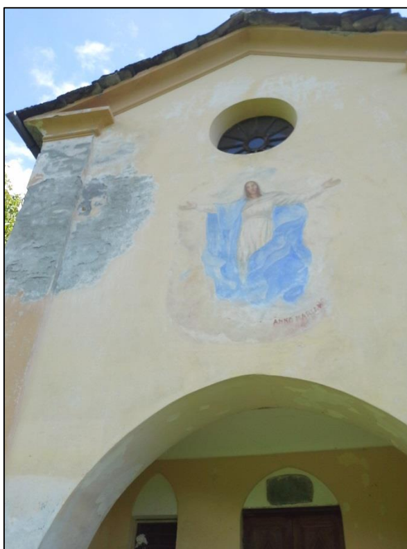
Facciata della cappella di Grun.
