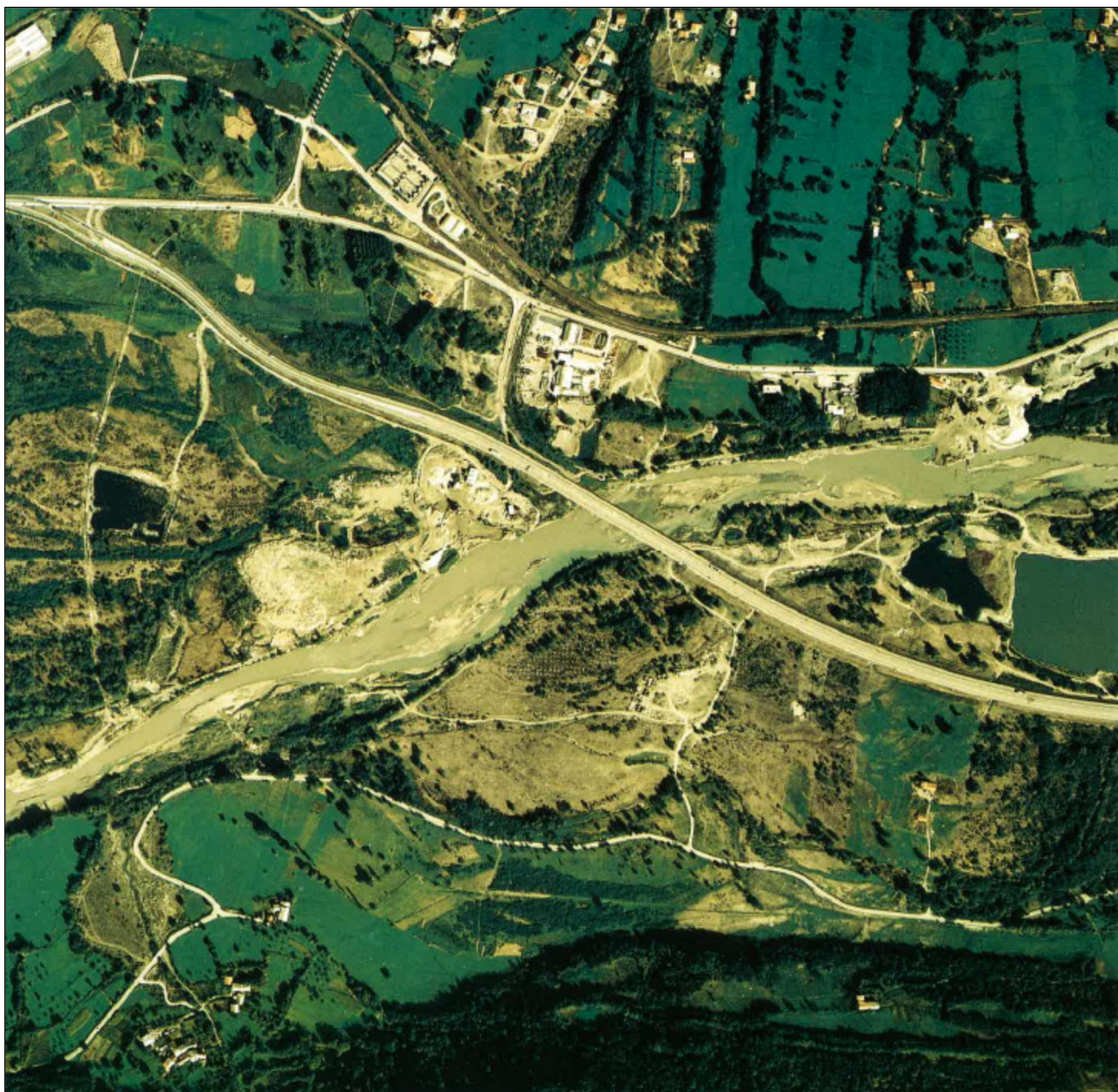
Fig. 13 - Svincolo autostradale di Aosta Est. Foto aerea da 3.850 m. 10 settembre 1974 (da R.A.V.A. 1998, p. 102).
