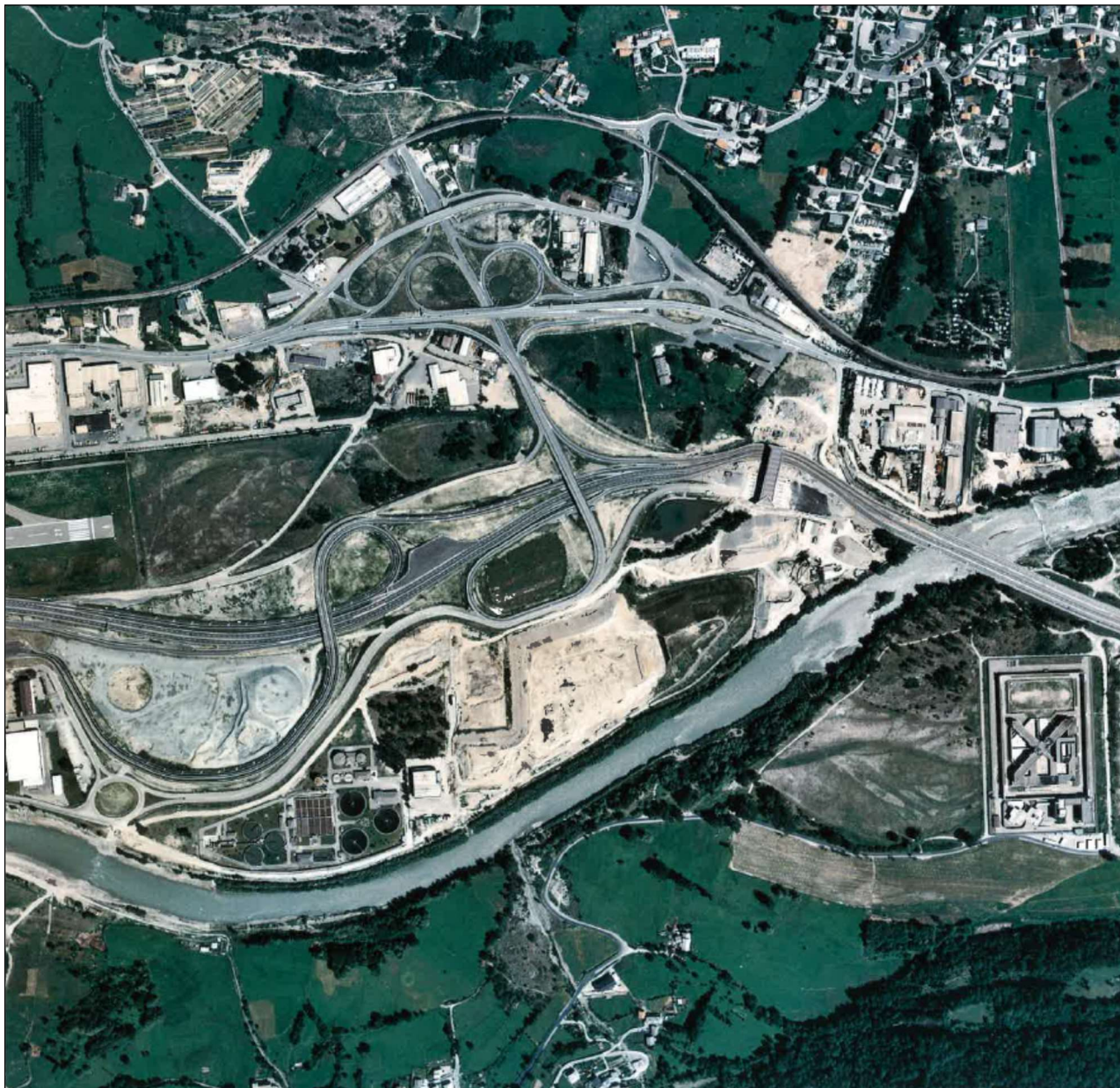
Fig. 15 - Svincolo autostradale di Aosta Est. Foto aerea da 2.540 m. 13 luglio 1997 (da R.A.V.A. 1998, p. 105).
