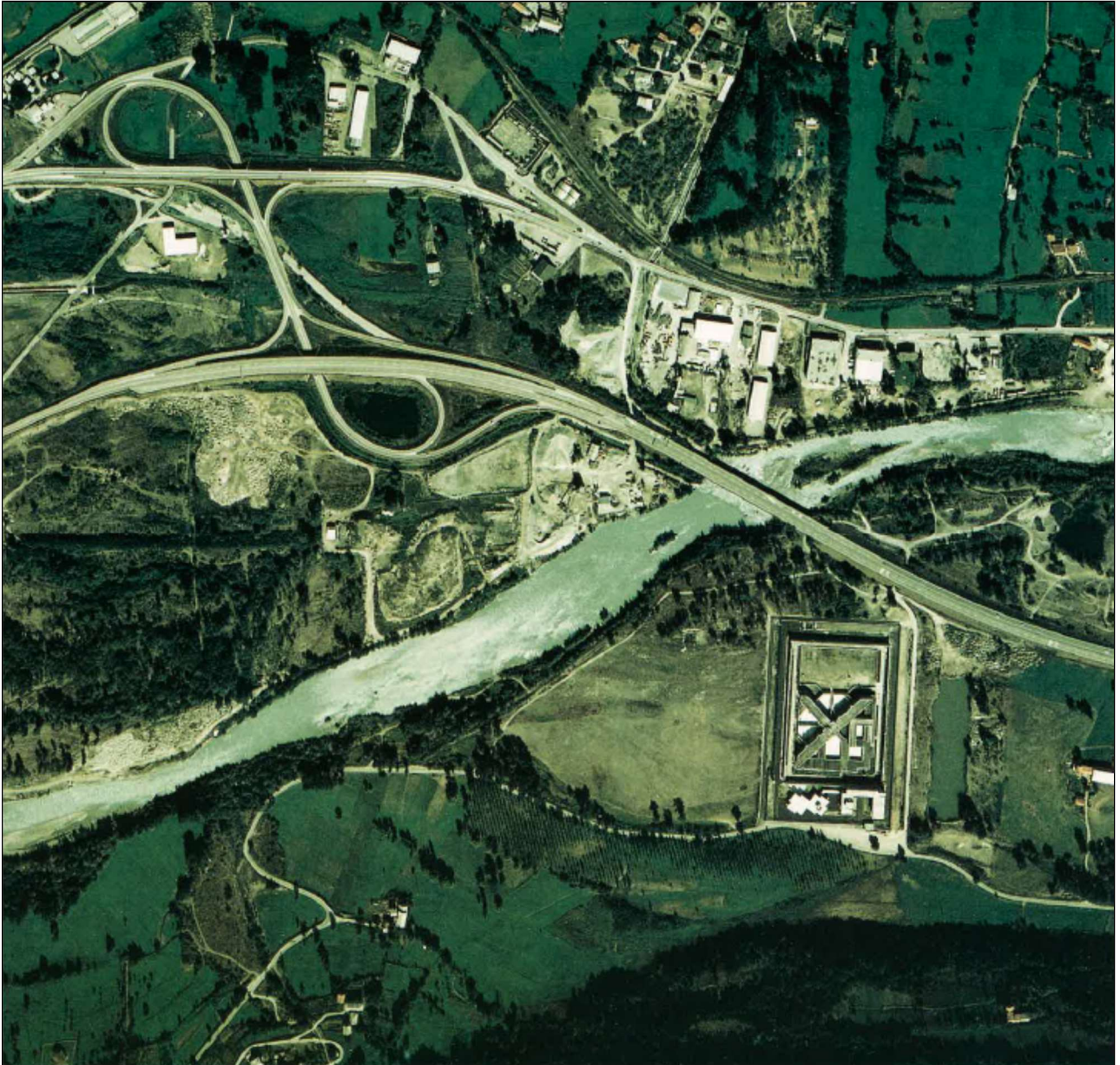
Fig. 14 - Svincolo autostradale di Aosta Est. Foto aerea da 3.040 m. 18 settembre 1983 (da R.A.V.A. 1998, p. 103).
