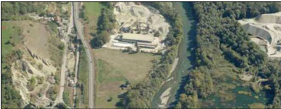
Alberatura ad alto fusto lungo le sponde della Dora Baltea
