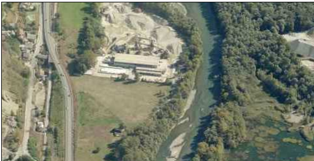
Settore oggetto d'intervento – situazione attuale
