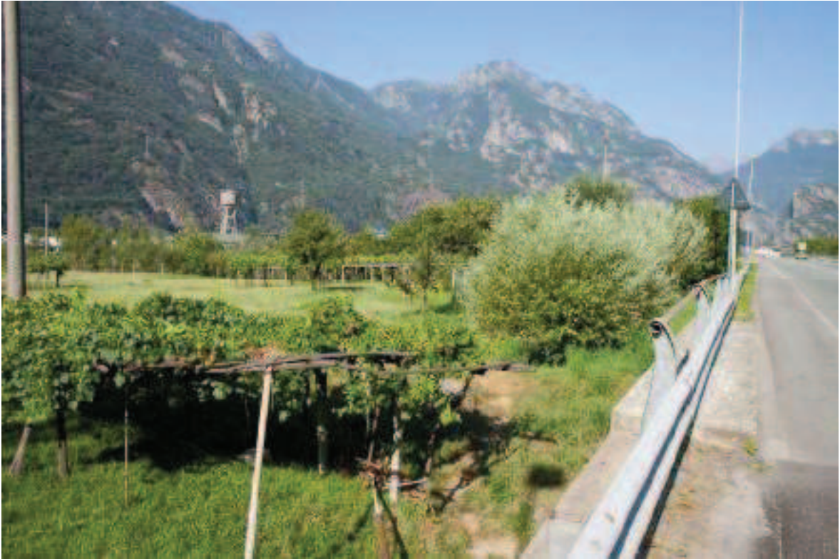
Foto 1: il punto di diramazione della condotta SNAM in loc. Perruchon di Pont Saint Martin, a destra la ss n° 26
