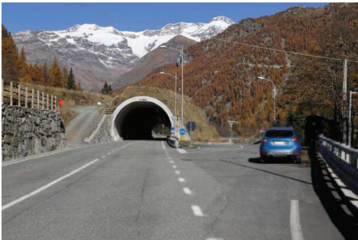
Foto 4: vista da valle della galleria artificiale in loc. Antene Gaveno, sulla destra la strada provvisoria realizzata dopo l'alluvione 2000 e che ora funge da accesso all'opera di presa sul t. Lys.
