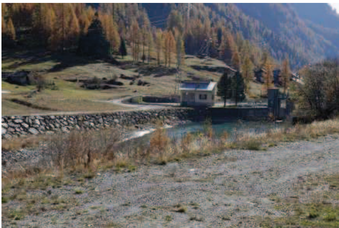
Foto 5: vista dell'alveo del t. Lys e dell'opera di presa in loc. Antene Gaveno nel tratto dove il progetto prevede un attraversamento in subalveo.
