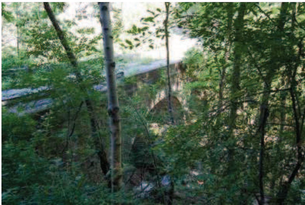
Foto 3: vista del ponte in pietra che supera il torrente Rechentier.
