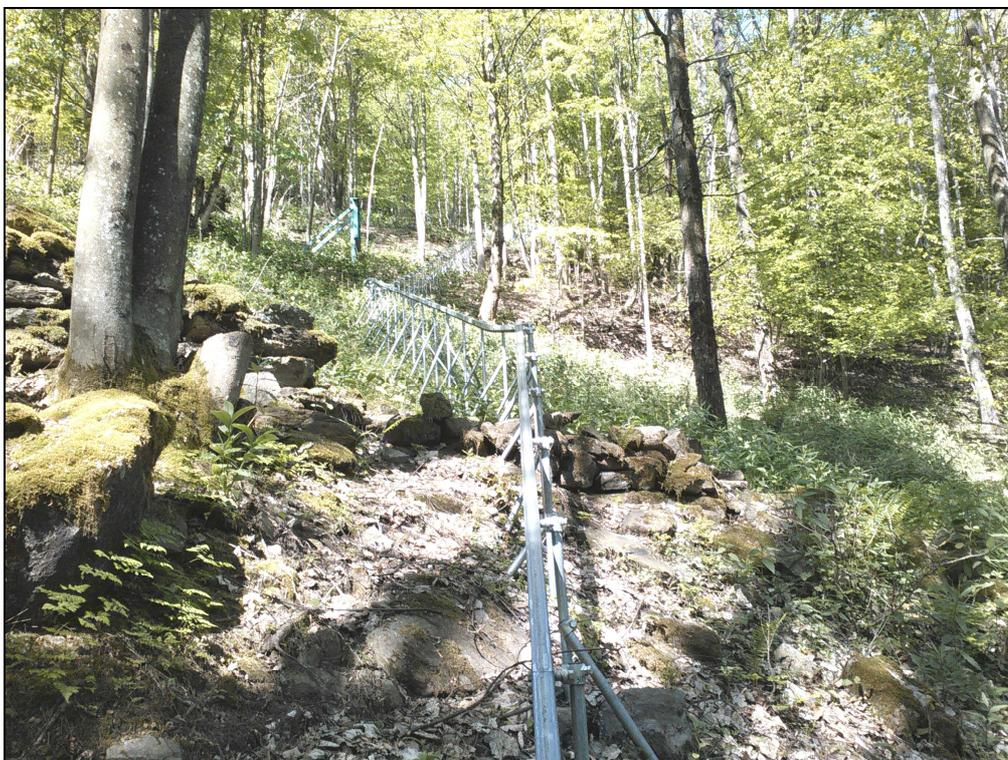
Fig.4-6 – Esempio monorotaia a cremagliera con sviluppo adattato alla morfologia
