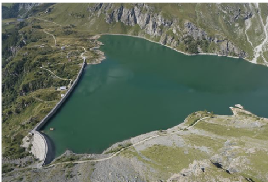
Foto 1.1 Vista aerea dello sbarramento di Cignana
