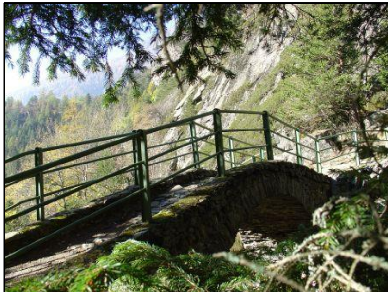
Il ponte Betenda
