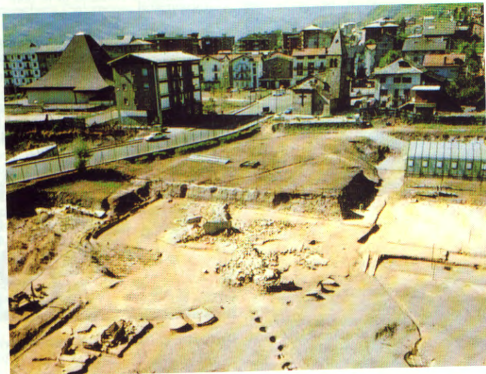
Vue d'ensemble du chantier
