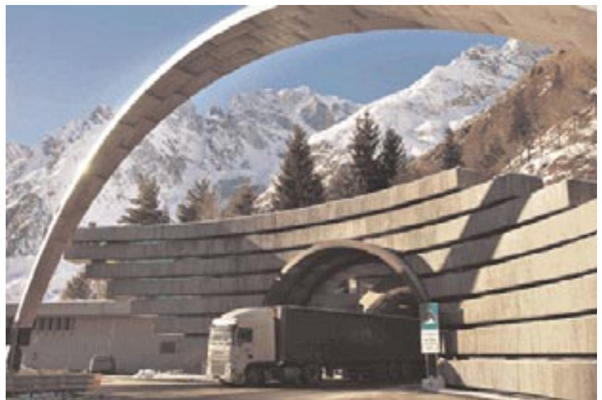
L'ingresso del Tunnel
