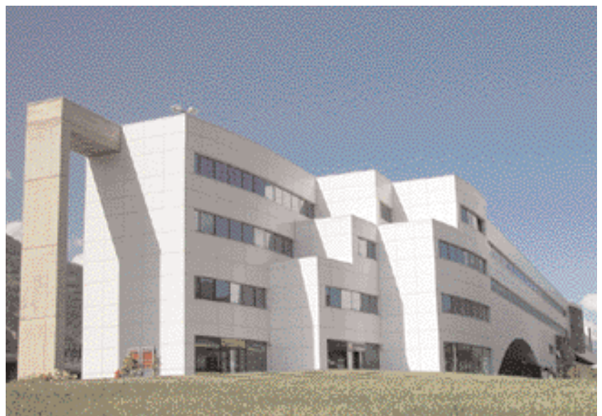
Le Centre de direction de l'Autoport
