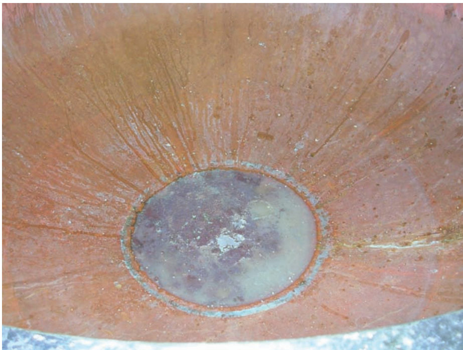
Fig. 5. Caldaia non correttamente pulita
