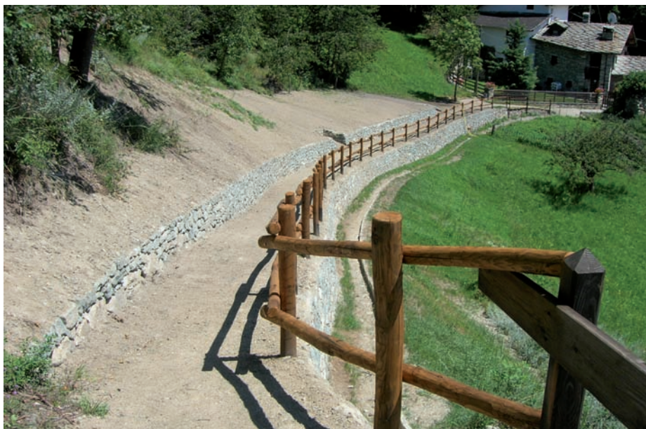
Sentiero in località Gorrey in Comune di Roisan - Ripristino del piano di calpestio, muratura in pietra e malta e posa staccionata in legno
