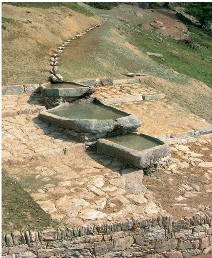
Località Truc in Comune di Lillianes - Ricostruzione antico canale irriguo
