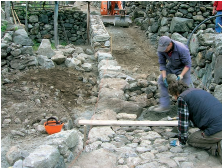
Località Reisen in Comune di Donnas Manutenzione viabilità rurale
