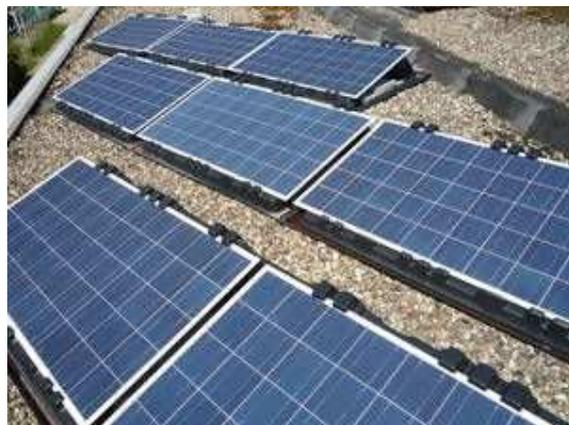
Realizzato in **polietilene riciclabile (HDPE)**, leggero (7,3 kg), facile da maneggiare durante l'installazione, il sistema è impilabile, necessitando quindi di meno spazio per l'immagazzinamento.
