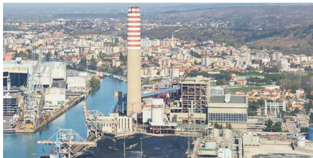
Una veduta dall'alto della centrale A2A di Monfalcone
