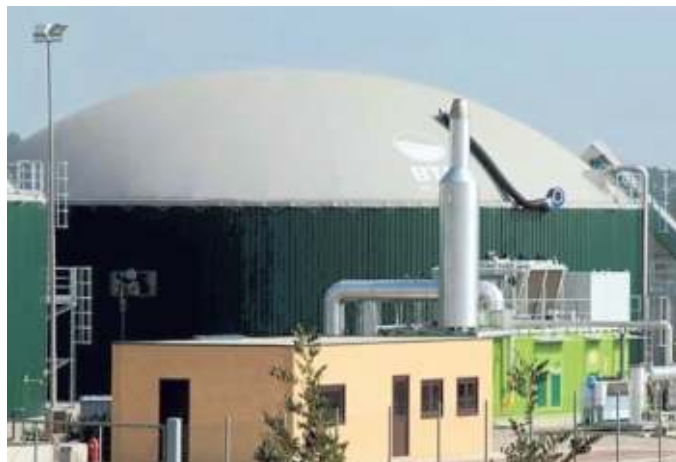
La centrale a biogas di Marmirolo, in provincia di Mantova
