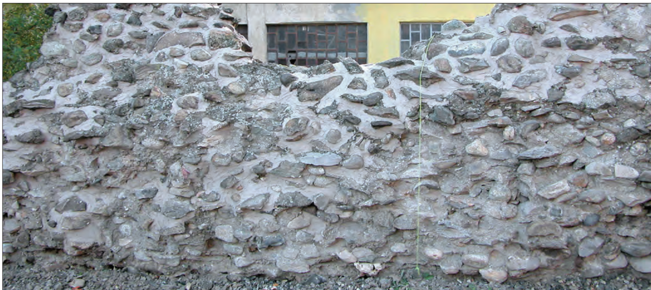
10. Lato ovest, via Torre del Lebbroso: copertine sottolivello e piani di deflusso dell'acqua realizzati in estensione (ID 5) con malte a base di calce idraulica Briigliadori, prima dell'armonizzazione cromatica (annerimento). (G. Di Carlo)
