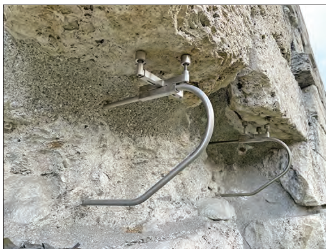
13. Lato sud, strada parallela a viale Matteotti, lato Stazione autolinee: mensole dinamiche in acciaio inox (ID 8-10). Si noti la slitta a croce con i pistoncini cilindrici sui 3 terminali. (C. Pedeli)
