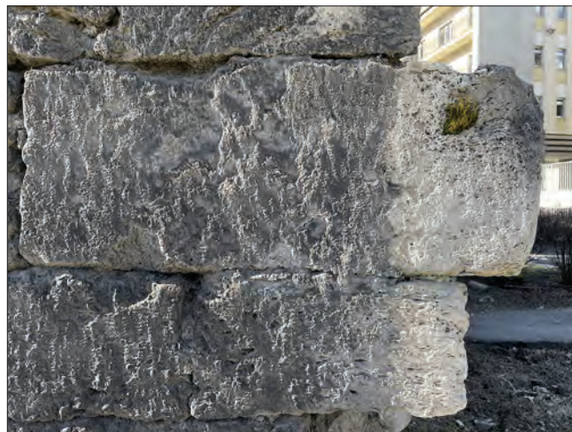
2a.-b. Annerimento sul paramento di travertino dovuto a: croste nere (a sinistra); deposito di particolato fine (a destra), l'estremità più chiare sono due zone pulite mediante microsabbiatura. (C. Pedeli)
