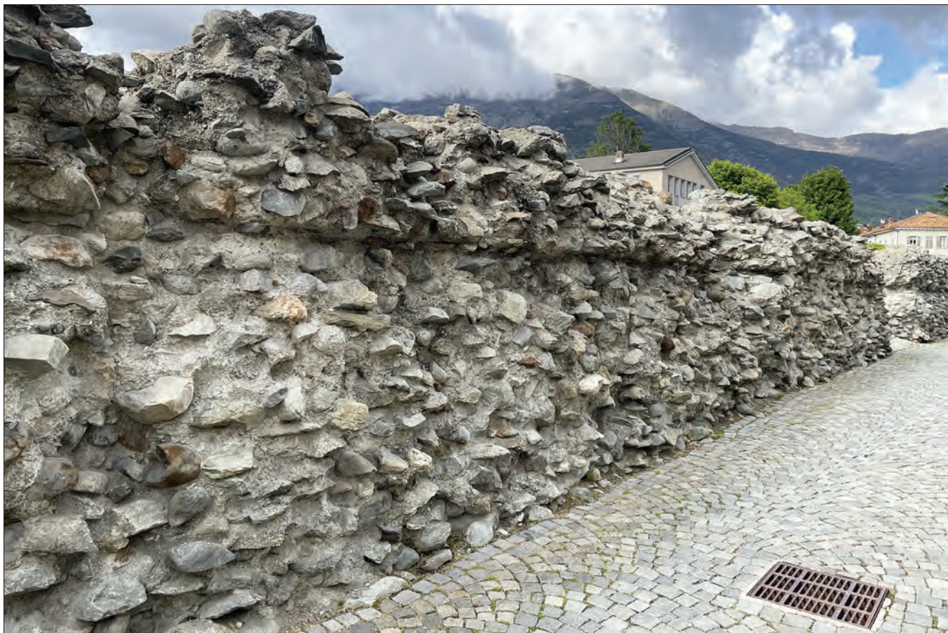
8. Lato nord, via Rey: vista generale di un tratto di muratura, dopo il restauro (ID 17), sabbiato e consolidato. Si notano le linee di demarcazione che evidenziano le gettate del sacco. (C. Pedeli)
