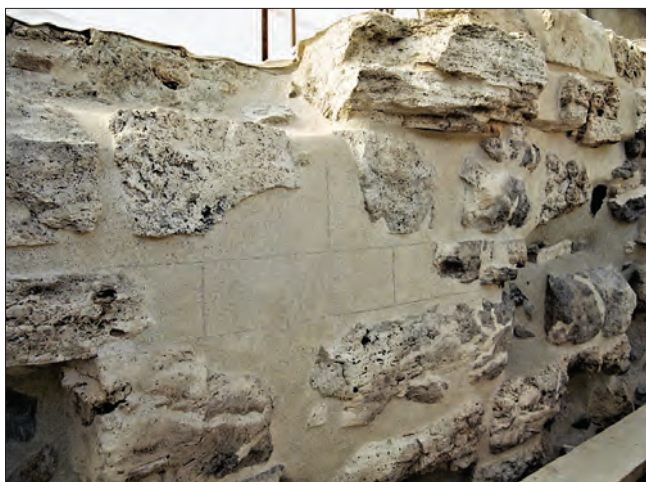
4-5. Lato est, via Vevey: a sinistra, integrazione del paramento in travertino realizzata in base allo schema geometrico ipotetico della tessitura originale (ID 6); a destra. degrado dopo 19 anni, sono presenti fessurazioni, rigonfiamenti, esfoliazioni e distacchi dell'intonaco nonché la sua perdita totale in alcune aree in cui emerge la tamponatura sottostante in mattoni e malta. (G. Di Carlo, C. Pedeli)
