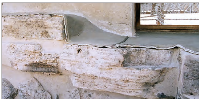
11. Lato est, via Vevey: scorcio di un segmento di copertina dinamica (grigia) appena realizzata (ID 6). Si intravede il giunto di dilatazione (ancora da colmare con il silicone) che unisce due moduli. (G. Di Carlo)
