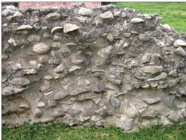
3. Lato ovest, via Torre del Lebbroso: nucleo consolidato in estensione (ID 3). Lo strato di finitura della malta è stato colorato affinché si armonizzasse con l'annerimento dovuto a deposito di inquinanti (zona superiore destra). (C. Pedeli)
