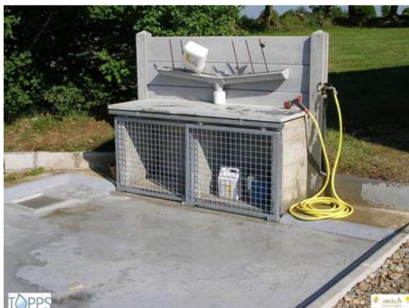
**Figura 7:** Esempio di area attrezzata per il riempimento ed il lavaggio delle irroratrici, pavimentata e dotata di sistema per la raccolta delle acque contaminate con agrofarmaci.
