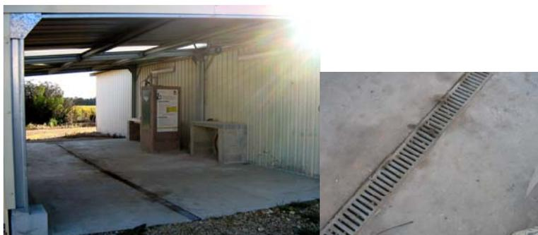
**Figura 18:** Area attrezzata per il riempimento ed il lavaggio delle macchine irroratrici, pavimentata e dotata di sistema di raccolta delle acque contaminate; a destra, particolare della griglia che immette al serbatoio di raccolta dei prodotti reflui.
