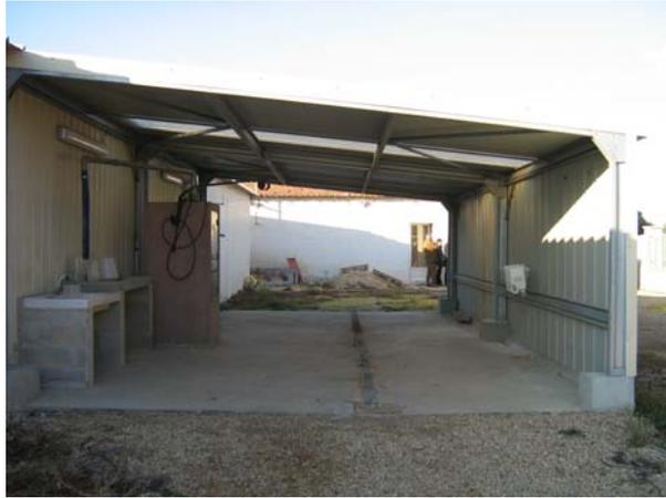
***Figura 62: Area attrezzata per il riempimento ed il lavaggio dell'irroratrice dotata di tettoia e pareti lavabili per poter attivare l'erogazione degli ugelli evitando la dispersione dell'acqua di lavaggio nell'ambiente.***
