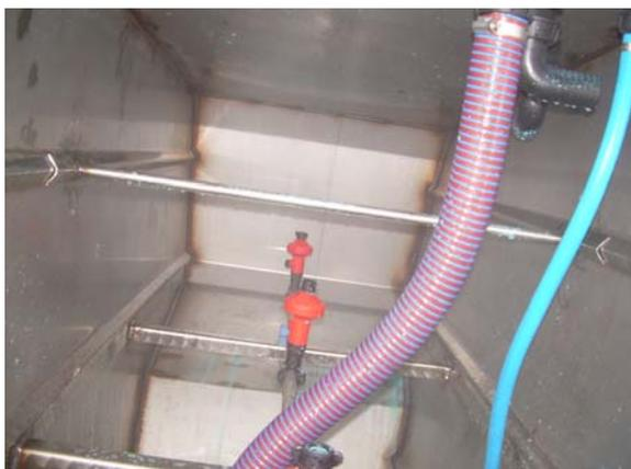
**Figura 47:** Coppia di ugelli rotativi posizionati all'interno di un serbatoio con un limitata presenza di elementi interni.
