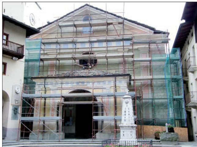
20. Primo intervento di pulitura (rimozione tinta sintetica).
