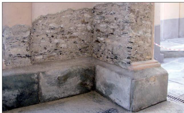
16. Particolare del protiro: rimozione d'intonaco ammalorato. (S. Leuratti)
