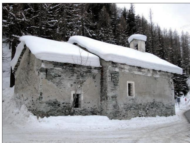
6. Degrado dell'intonaco causato dall'accumulo di neve durante le operazioni di sgombero della sede stradale.
