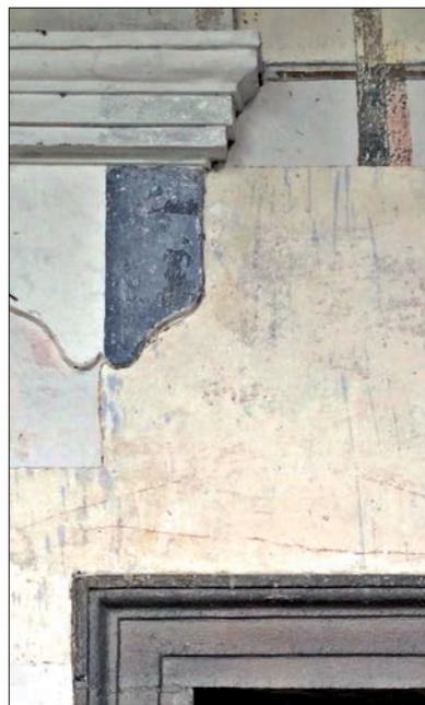
12. *Particolare delle superfici originali conservate (capitello e parete di fondo) rinvenute durante la rimozione degli strati di tinteggiature e scialbi soprammessi, realizzati durante precedenti interventi.*
