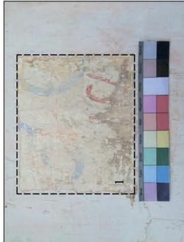
STRATO 1: particolare della finitura liscia a calce di colore bianco aderente all'intonaco di supporto probabilmente risalente all'XVIII sec; con tracce di bricioli
