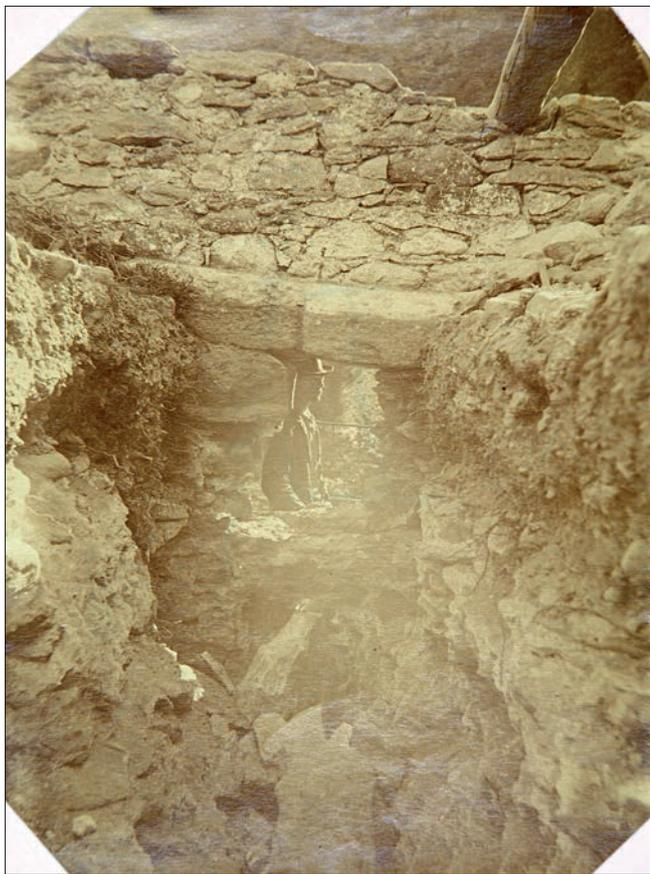
2. Saggio esplorativo a ridosso del parapetto del ponte. Sono visibili i diversi strati di riempimento della struttura.
