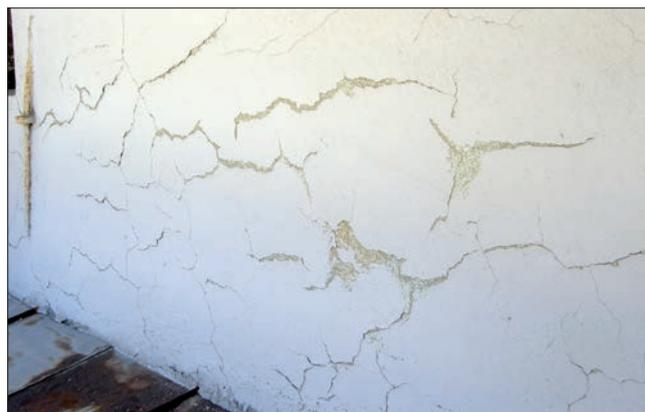
11. Particolare del timpano: degrado della tinta in corrispondenza delle crepe da ritiro dell'intonaco.
