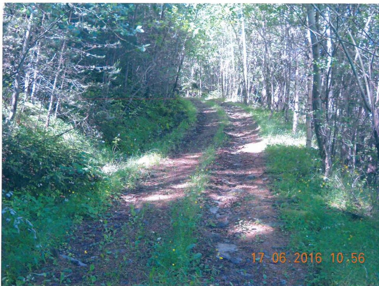
Lavori di ripristino percorribilità sulla pista AIB denominata "Arpeille" tra le località Verthuy e Cloutra nei comuni di Pontey e Chambave
