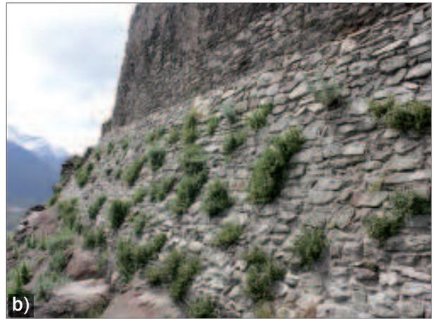
9. Porzione della scarpa del muro di cinta sud-ovest: a) al termine dei lavori, b) dopo circa un anno. È evidente l'importanza di programmi di manutenzione continua, come il trattamento biocida delle superfici, già subito dopo il completamento degli interventi di recupero.
