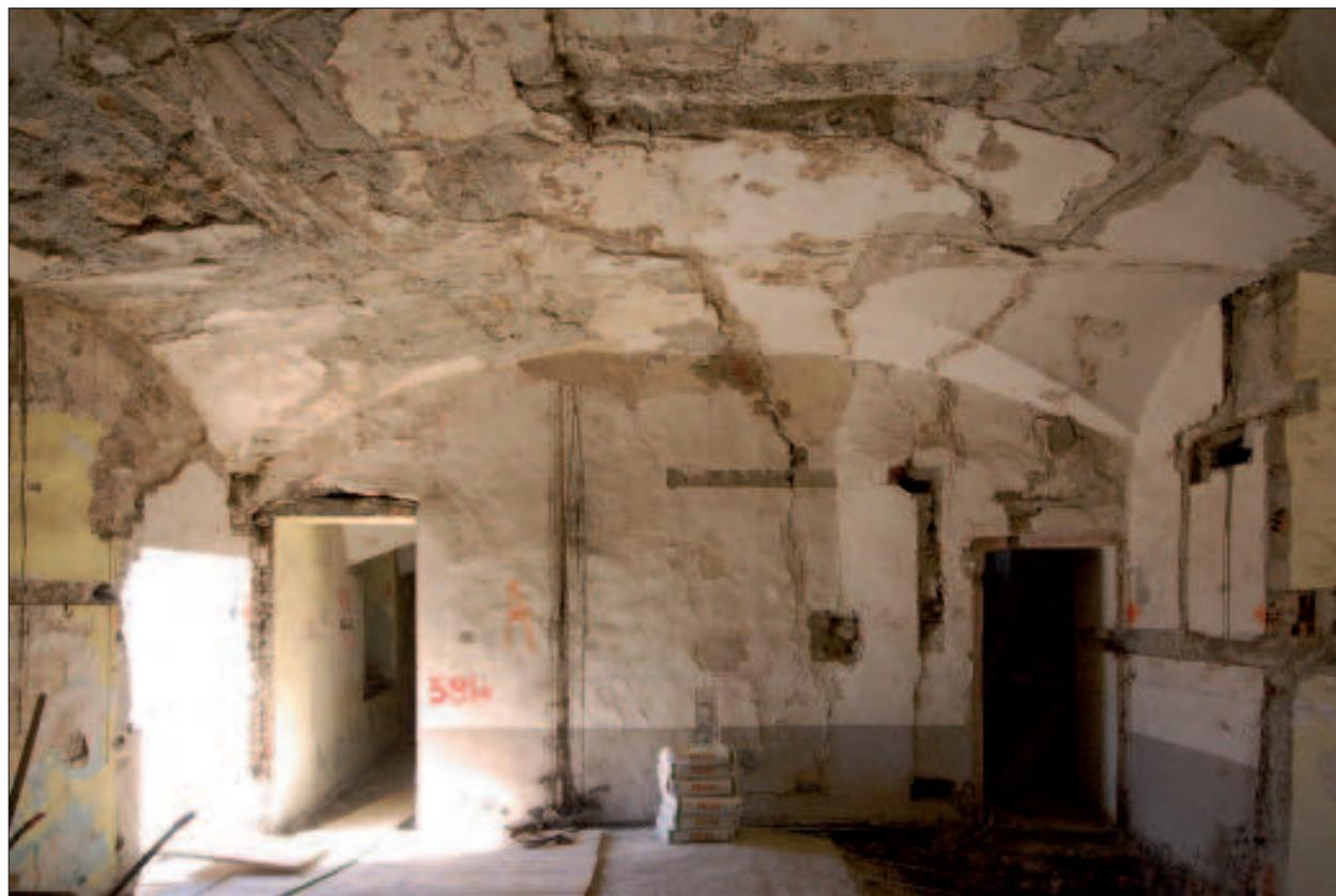
3. Situazione del degrado nel salone voltato al piano terreno, ora Sala lettura, prima dei lavori.
