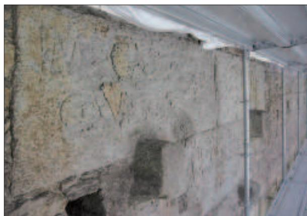
2. Iscrizione originale: dettaglio del grado di deterioramento prima dell'intervento di restauro. (C. Pedeli)
