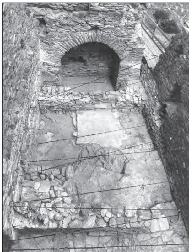
1. Scavo nel 1989 e fase del raddrizzamento tramite tiranti. (F. Agnello)
