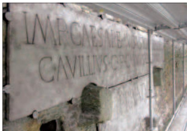
1. Copia in resina già posizionata in parete e sovrapposta all'iscrizione originale: dettaglio di alcuni elementi del sistema di ancoraggio. (C. Pedeli)
