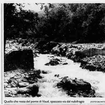
Quello che resta del ponte di Vaud, spazzato via dal nubifragio (FOTO SALVATO)
