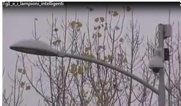
I corpi illuminanti utilizzati sono in parte a LED in parte a sodio ad alta pressione per l'illuminazione stradale
