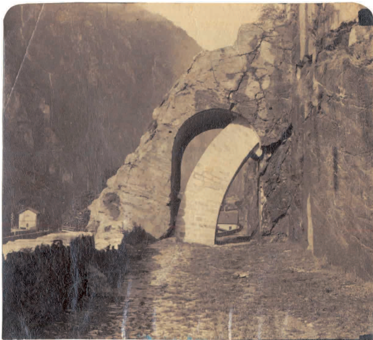
6. Ottavio Germano, l'Arco romano di Donnas dopo la realizzazione del pilastro di sostegno , stampa all'albumina, 70x77 mm, 1890.
