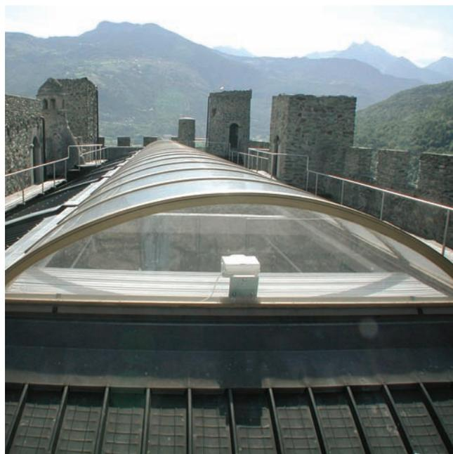
2. Particolare della copertura semitrasparente.
