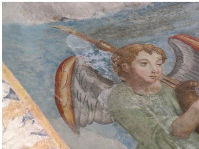
6. Volta del fornice, dettaglio di angelo musicante in cui si evidenzia il disgregamento della pellicola pittorica prodotto dalle efflorescenze saline. (R.. Cristiano)
