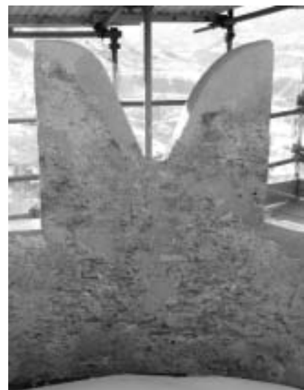
Merlo 07 I della torre nord-est dopo l'intervento di sostituzione con malta di calce. (A. Novel)
