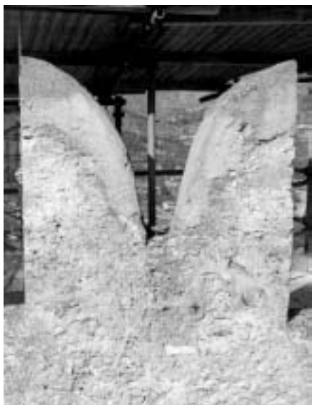
Merlo 07 I della torre nord-est prima dell'intervento di asportazione delle parti in cemento. (A. Novel)
