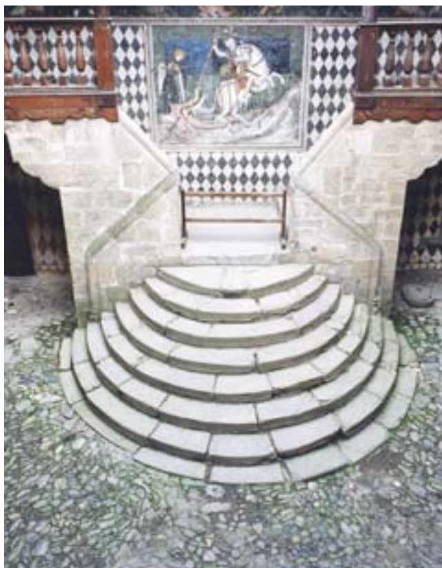
Scalinata corte interna. (P. Fioravanti)
