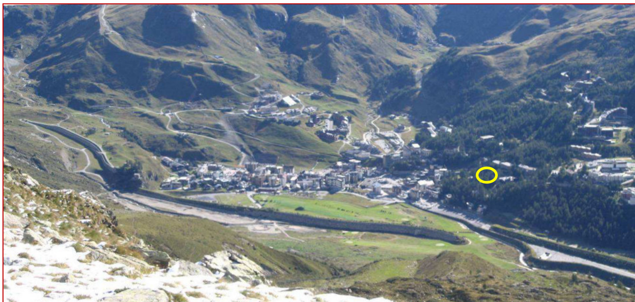
Fig. 17 - Panoramica dal versante occidentale sulle opere paravalanghe (foto archivio CVRV)
