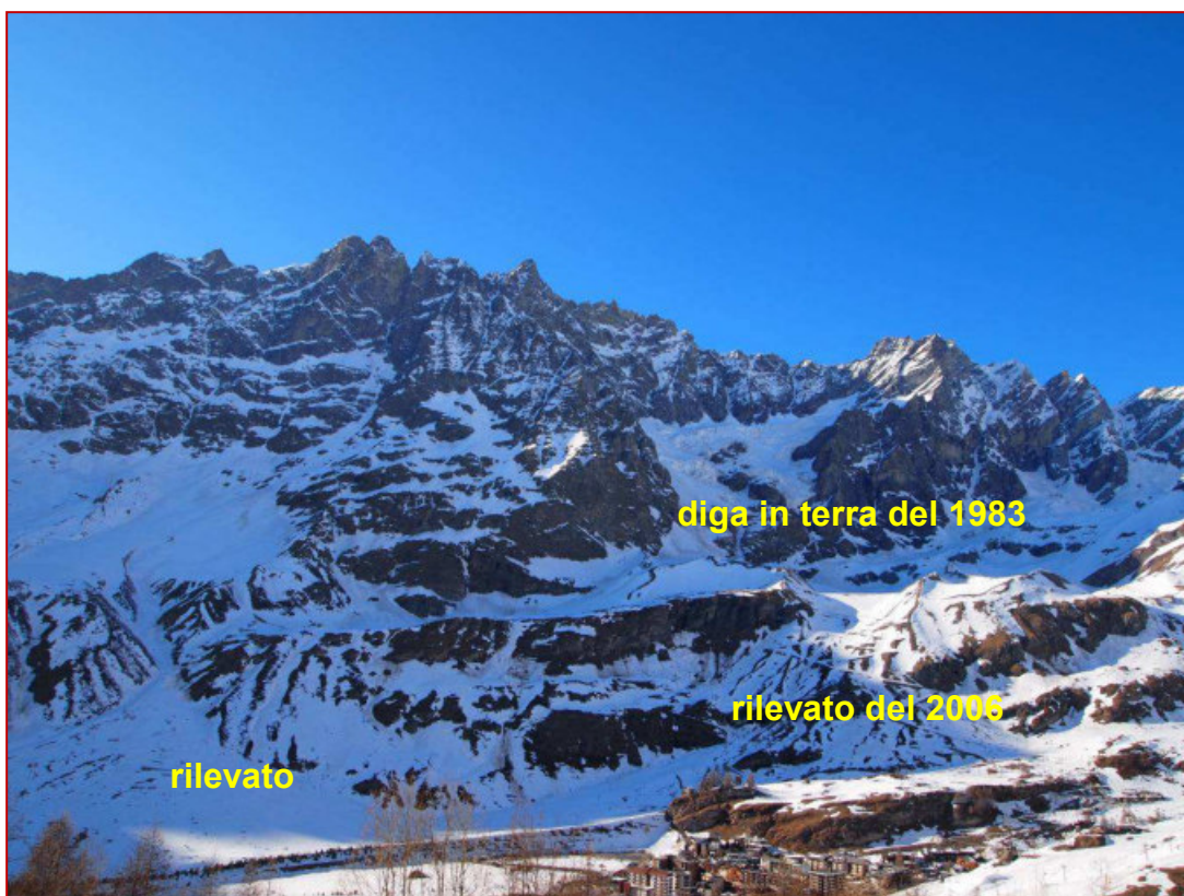
Fig. 16 - Panoramica sul settore settentrionale della conca del Breuil con indicazione delle opere realizzate a protezione dalle valanghe di Maberger e Mont-Tabel
