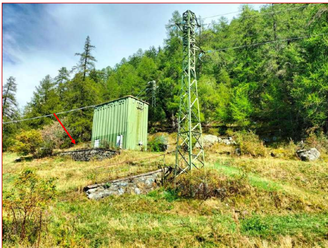
Fig. 3 – Vista da SW della cabina DEVAL, con l'area in cui è prevista la realizzazione del basamento
