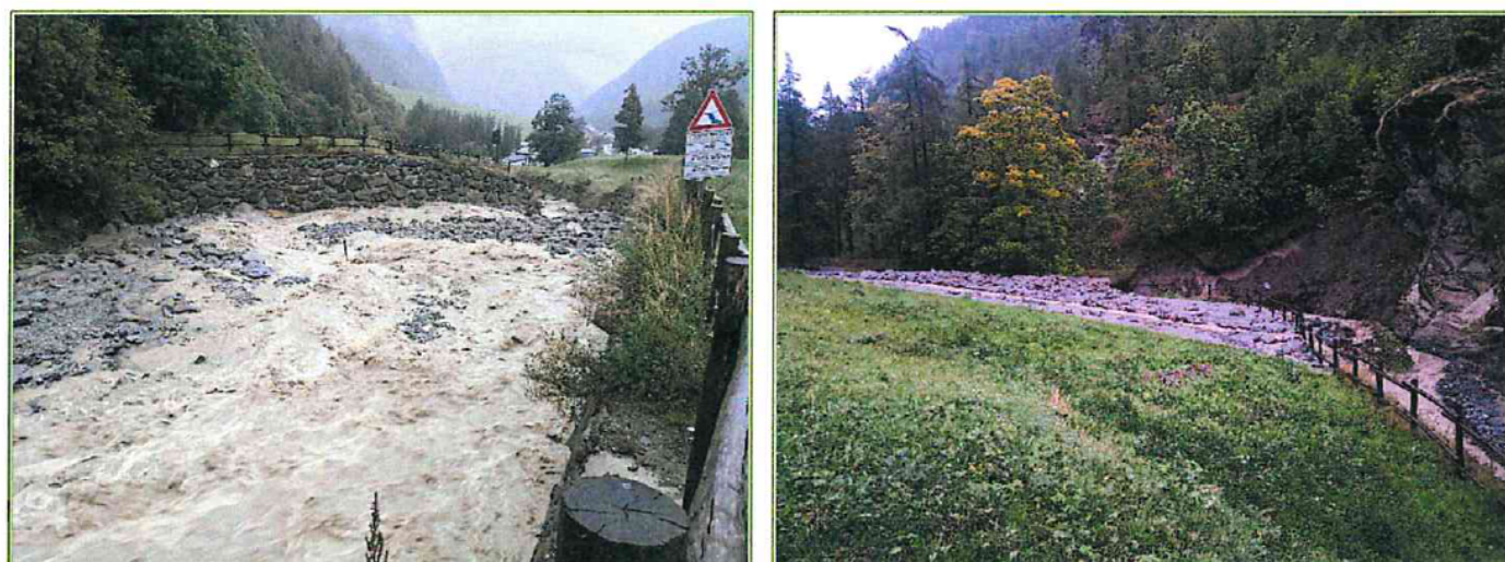
FOTO 3 e 4 : vista del torrente immediatamente a valle del tratto dove lo stesso è esondato a valle della loc. Vaud e vista da valle in sponda DX della parte finale del tratto esondato
