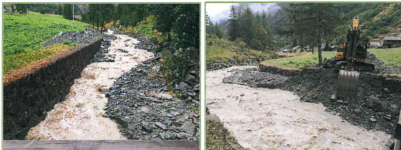
FOTO 1 e 2 : vista rispettivamente del tratto a monte e del tratto a valle del ponte pedonale in loc. Vaud
