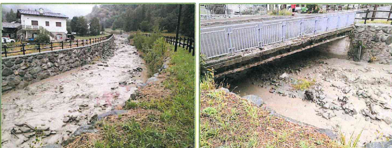
FOTO 3 e 4 : vista rispettivamente del tratto a monte e della luce residua risultante del ponte della strada comunale in località Vouèces
