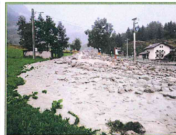
FOTO 4: vista da valle della sede stradale invasa dalla colata detritica in località La Condémine
