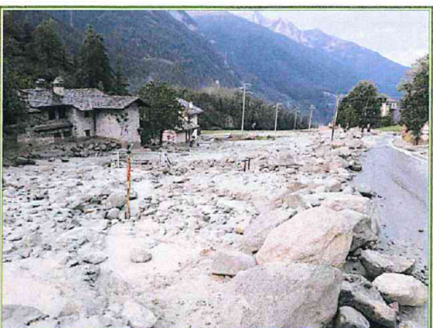
FOTO 11: vista della località La Condémine da monte e a destra la sede stradale
