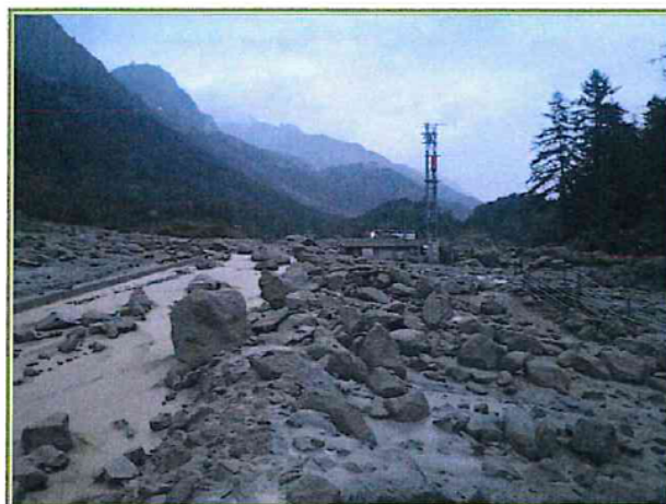
FOTO 9 e 10: vista da valle e in particolare della vasca dell'acquedotto comunale interessata dal detrito depositatosi
