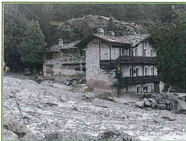
FOTO 7: particolare dell'edificio più a monte della località La Condémine invaso dalla colata detritica
