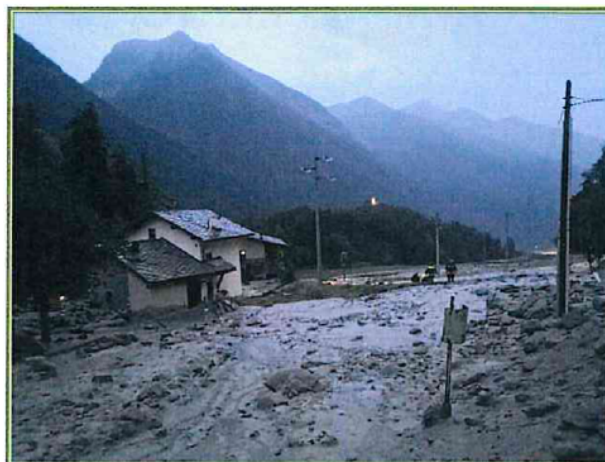
FOTO 8: vista da monte di un secondo edificio in località La Condémine invaso dalla colata detritica
