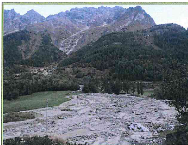
FOTO 5: vista del Mont Traversagne (Q. 3.000 m) all'apice del bacino idrografico del torrente Varère
