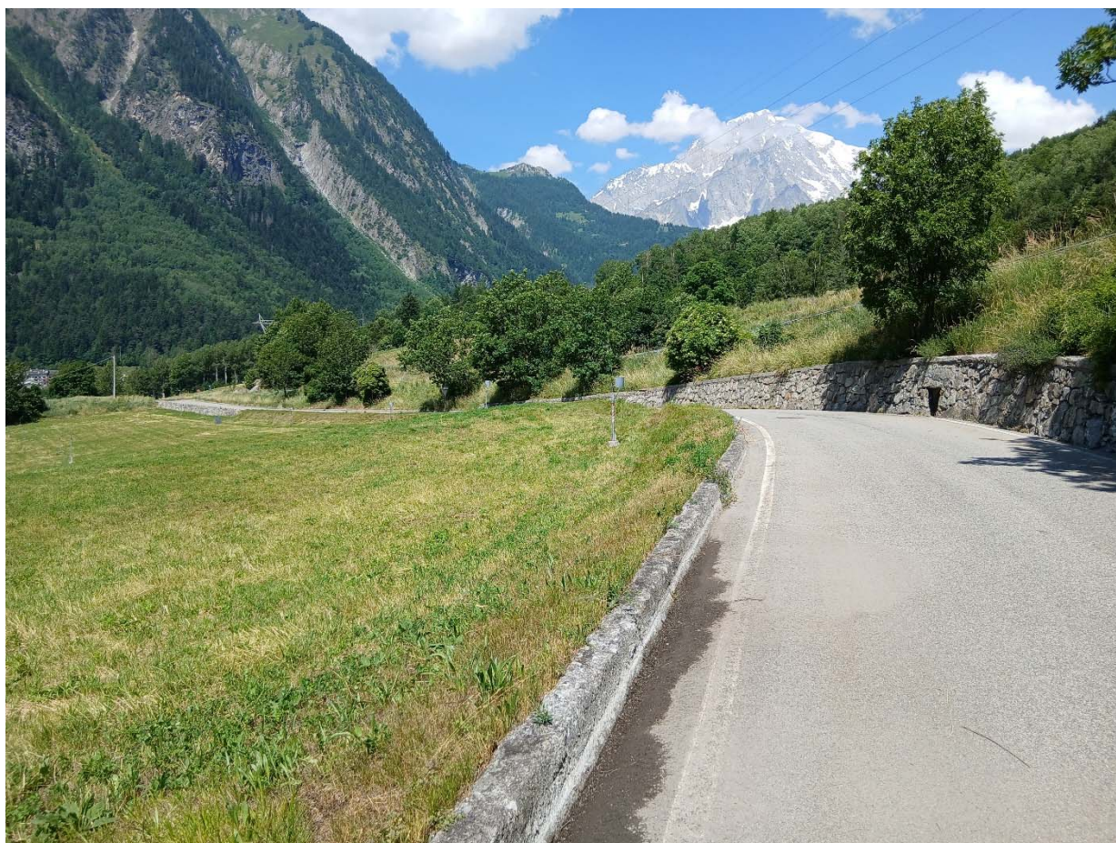
Strada comunale Route de Chenoz
