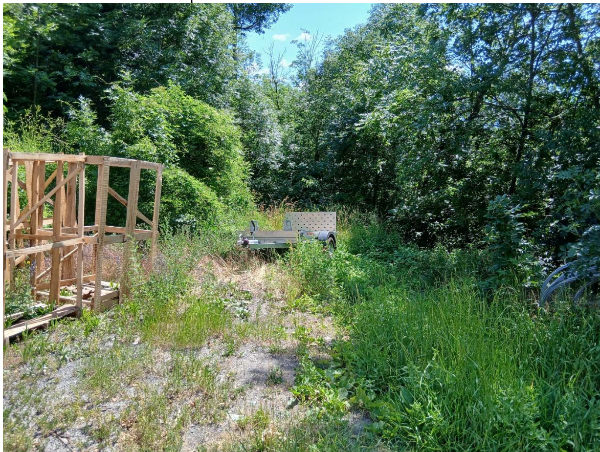
Parte terminale del ripiano di raccordo con la strada comunale Route de Chenoz
