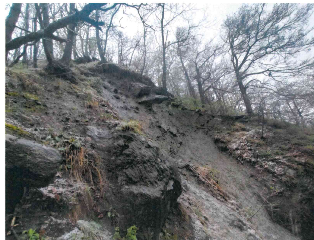
FOTO 1: vista da valle della nicchia di distacco
