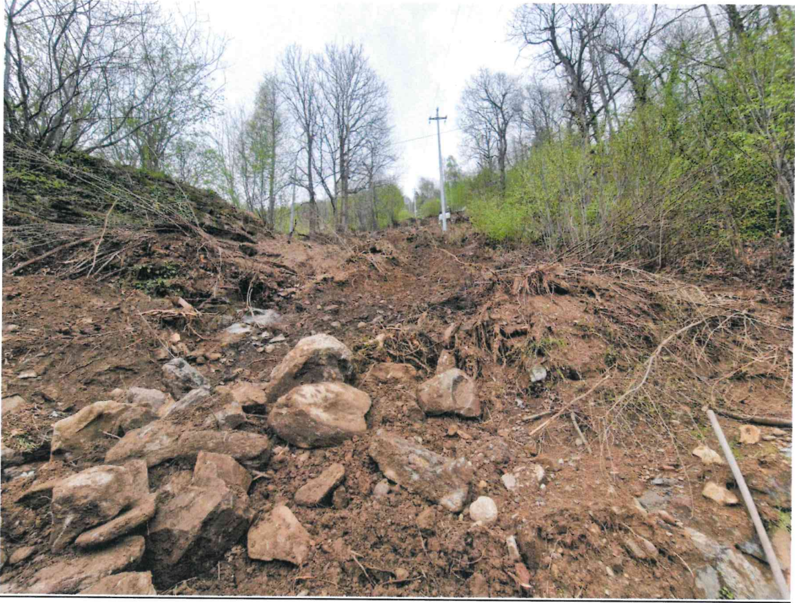
FOTO 1 : vista a valle della frana nei pressi della Loc. Mattet
