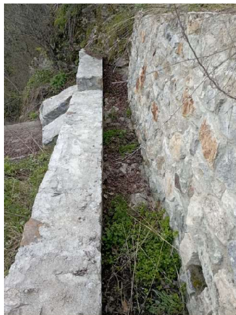
PARTENZA DEL CANALE IN MURATURA SOTTO LA STRADA COMUNALE, DOVE SARA' REALIZZATO IL PRIMO POZZETTO DI ROTTURA E PARTENZA TUBAZIONE A PARETE STRUTTURATA DIAM. 400 mm
