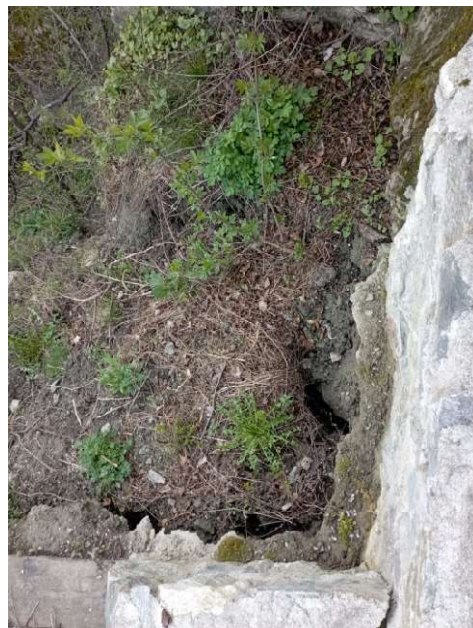
SCALZAMENTO DEL PIEDE DEL CANALE IN MURATURA PER CEDIMENTO TERRENO
