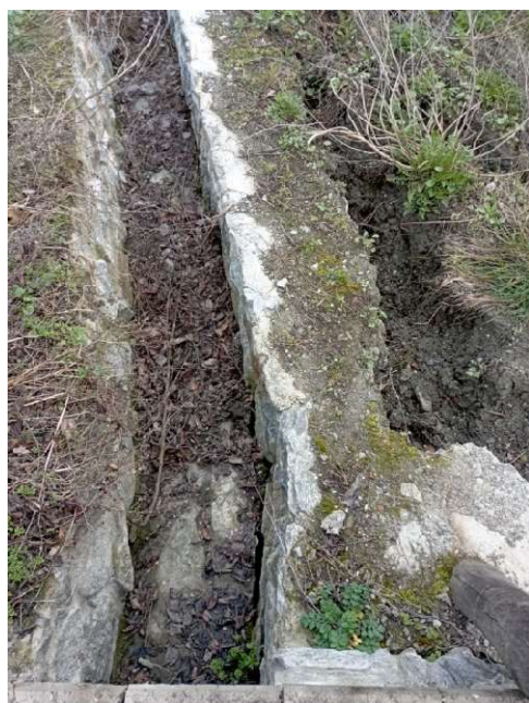
TRATTO DI CANALE AMMALORATO E DANNEGGIATO, CHE VERRA' DISMESSO E REINTERRATO MEDIANTE RIPIROFILATURA DELLA SCARPATA
