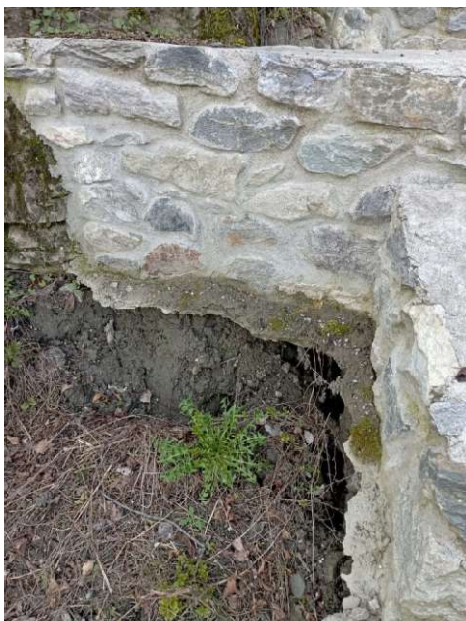
SCALZAMENTO DEL PIEDE DEL CANALE IN MURATURA PER CEDIMENTO TERRENO
