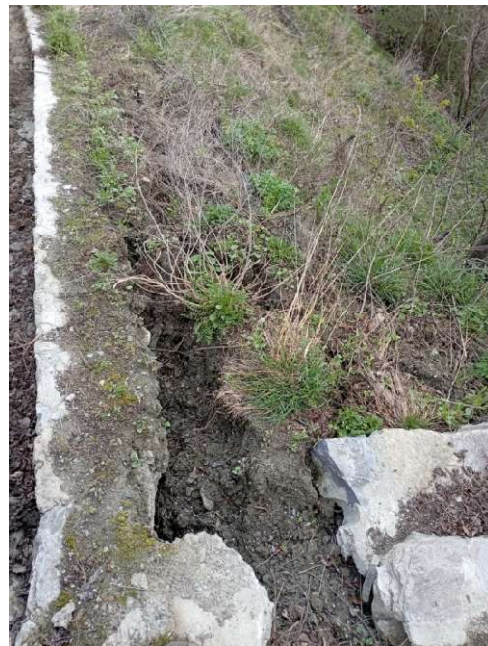
TRATTO DI CANALE AMMALORATO E DANNEGGIATO, CHE VERRA' DISMESSO E REINTERRATO MEDIANTE RIPIROFILATURA DELLA SCARPATA
