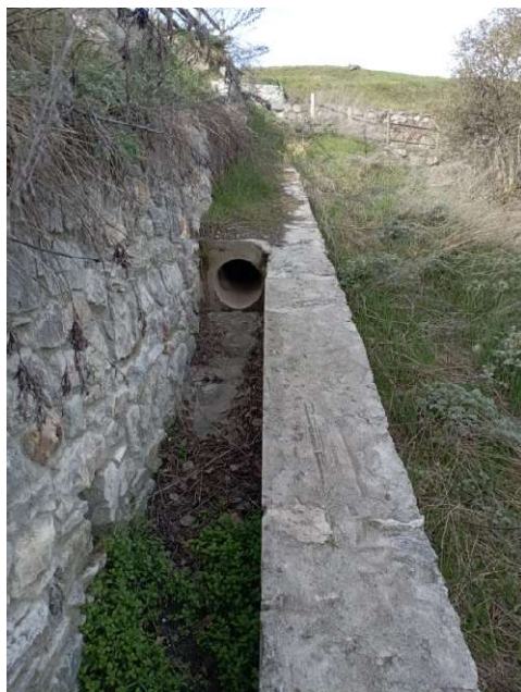
PARTENZA DEL CANALE IN MURATURA SOTTO LA STRADA COMUNALE, DOVE SARA' REALIZZATO IL PRIMO POZZETTO DI ROTTURA E PARTENZA TUBAZIONE A PARETE STRUTTURATA DIAM. 400 mm
