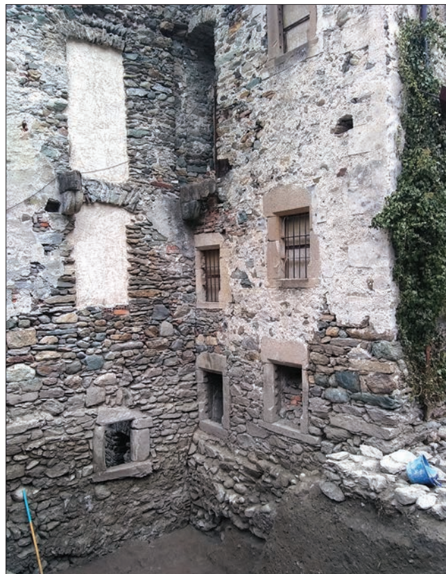
5. Saggio 3, vista da sud dei prospetti del corpo scalare quattrocentesco (USM 12, a destra) e del corpo di fabbrica occidentale (USM 11, a sinistra). (G. Sartorio)
