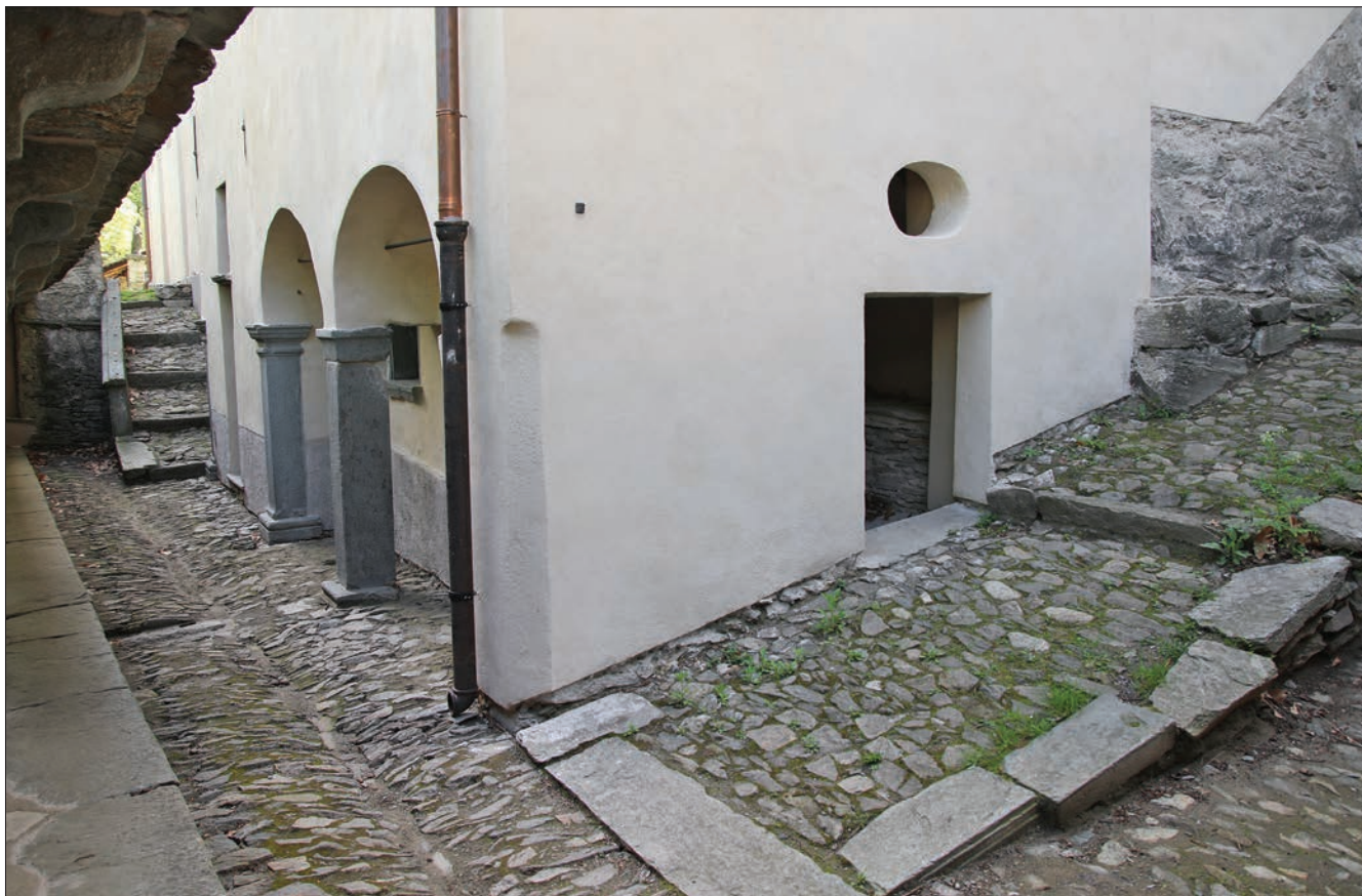
14. Veduta dell'angolo nord-ovest. (D. Turcato)
