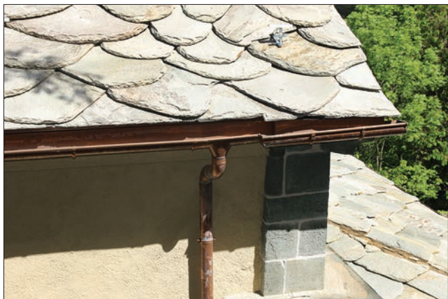
8. Particolare della copertura e della grondaia sud-est. (D. Turcato)
