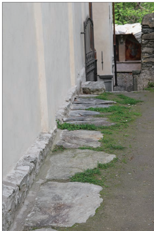
10. Passaggio a nord verso valle. (D. Turcato)
