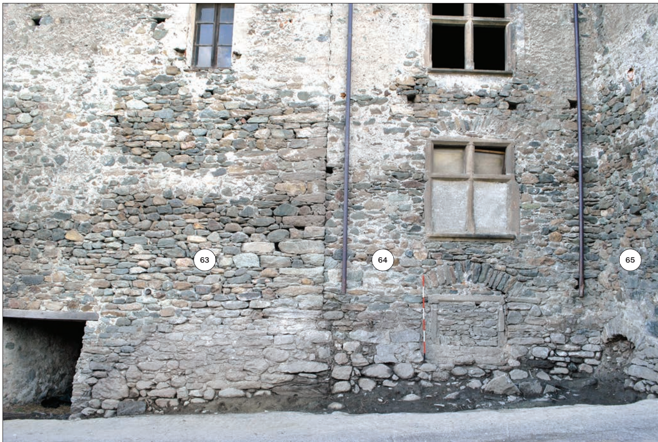
13. Prospetto settentrionale della casaforte. (F.T. Studio Srl)
