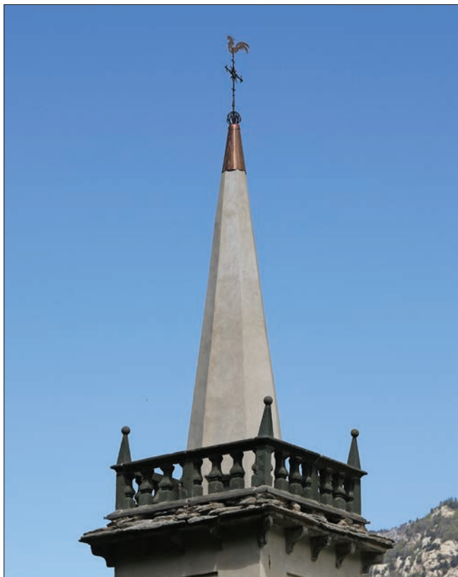
18. Particolare della cuspide, del tettuccio e della balaustra del campanile. (D. Turcato)
