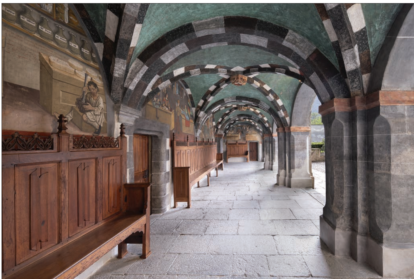
35. Il porticato dopo la ricollocazione degli arredi lignei restaurati. (G. Olivero)
