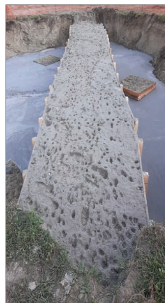
2. Il muro USM 7 con la protezione prima della posa delle fondazioni del sostegno Terna P101. (Cristellotti & Maffeis Srl)
