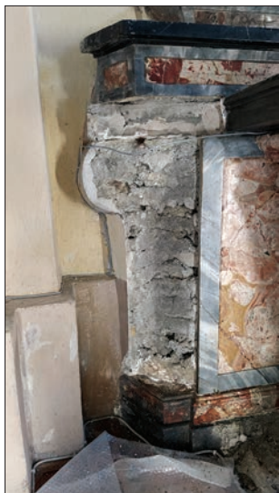
14a.-b. Il degrado del pilastrino di sinistra ne ha richiesto il completo smontaggio. (Studio Rinetti Srl)
