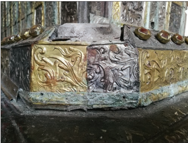
37a.-c. Il vistoso degrado causato sulle lamine metalliche dai fenomeni di corrosione. (V. Borgialli)
