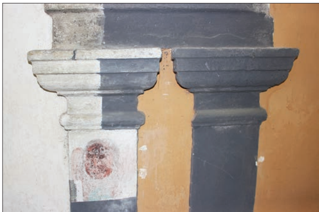
23. Parete del portico durante la rimozione della ridipintura dai peducci. (M.G. Bonollo)
