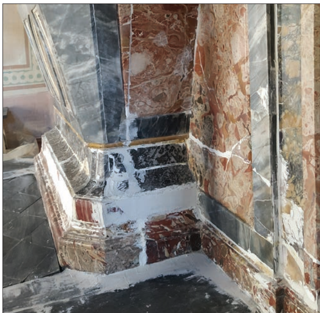
15. Il lato destro durante la stuccatura delle lacune e dei giunti. (Studio Rinetti Srl)
