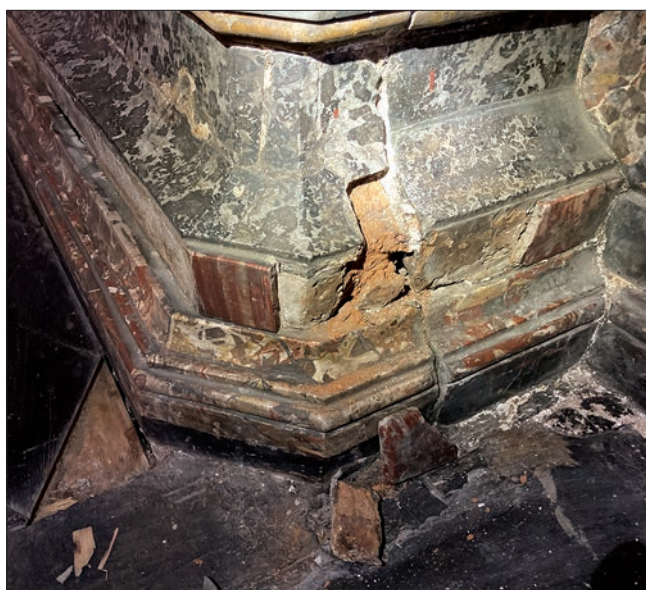
12. Il lato destro della mensa prima del restauro. (Studio Rinetti Srl)
