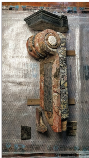
14a.-b. Il degrado del pilastrino di sinistra ne ha richiesto il completo smontaggio. (Studio Rinetti Srl)
