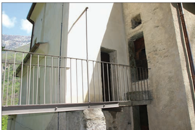
16. Ingresso al campanile e alla stanza dell'eremita sull'angolo sud-ovest. (D. Turcato)
