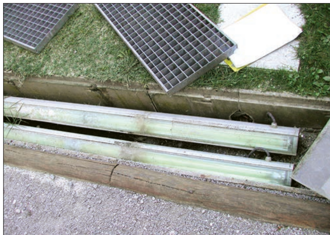
3. Corpi illuminanti al neon inseriti nella canalina da sostituire. (A. Novel)
