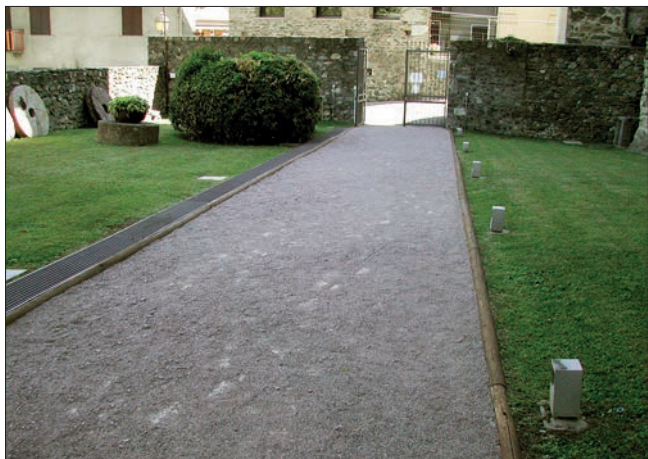
2. Viale di ingresso prima dei lavori. (A. Novel)
