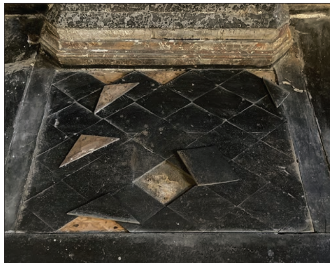
13. Le tessere lignee della pedana erano malferme e intrise di umidità. (L. Pizzi)
