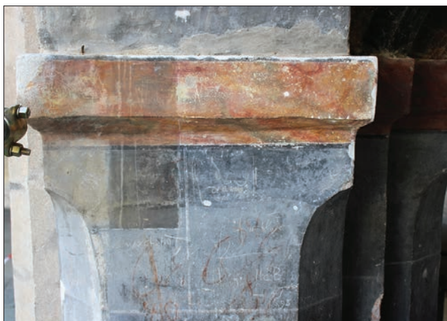
27. Pilastro del portico: il tassello a sinistra documenta lo stato della superficie prima della pulitura. (M.G. Bonollo)
