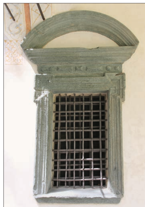
12.-13. Finestre con doppia inferriata: sulla facciata nord, in alto, a sinistra del portone d'ingresso, in basso. (D. Turcato)
