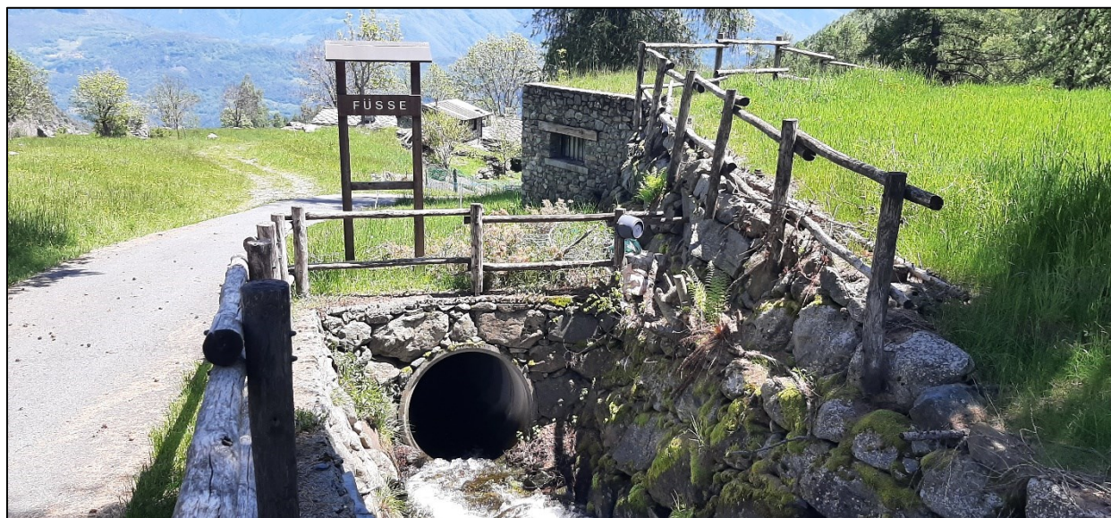
FIGURA 6-15 IMMAGINE DELL'IMBOCCO DELLA TOMBINATURA DEL T. PELODE
