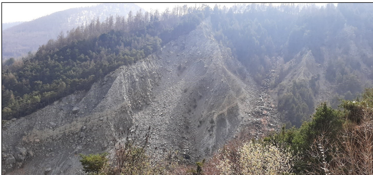
FIGURA 4-5 VISTA DELLA SCARPATA TERRAZZO DI FUSSE
