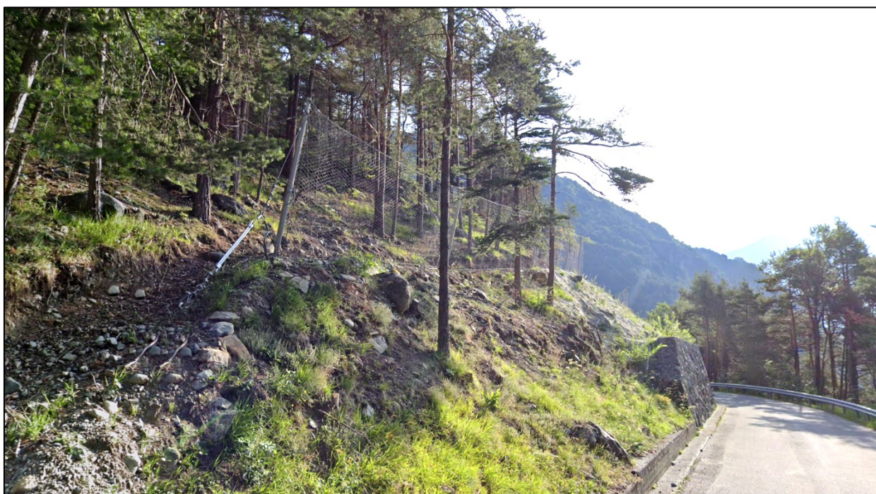
FIGURA 6-8 BARRIERE PARAMASSI A MONTE DELLA VIABILITÀ COMUNALE
