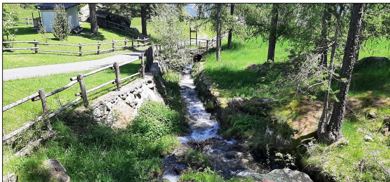
FIGURA 6-14 IMMAGINE DEL TRATTO DEL T. PELODE REGIMATO CON OPERE SPONDALE CON EVIDENZA A VALLE DELLA TOMBINATURA
